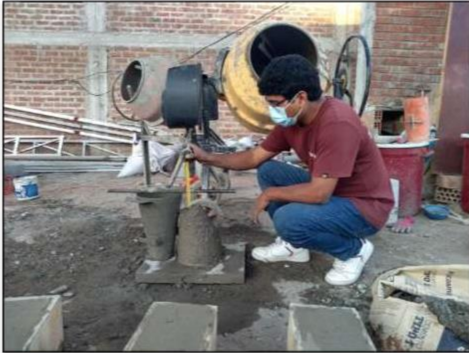
Figura 9: Ensayo de revenimiento o slump
