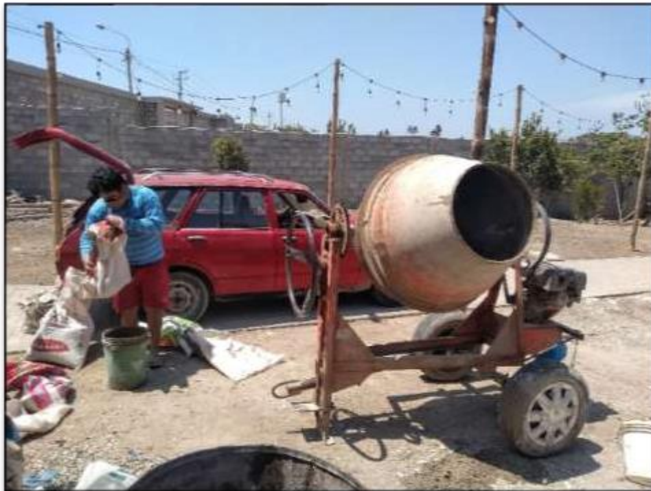
Figura 10: Fabricación del concreto con trompo mezclador
