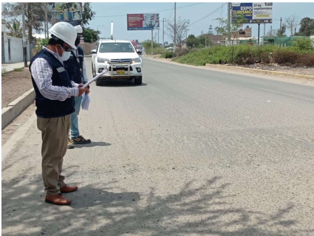
Imagen n°12- Identificación de fallas PL-Calzada Margen Izquierda.
