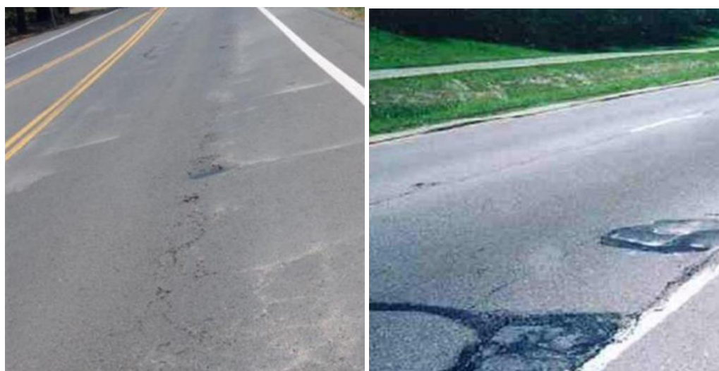
Figura 18. Afloramiento de mortero (AM).
