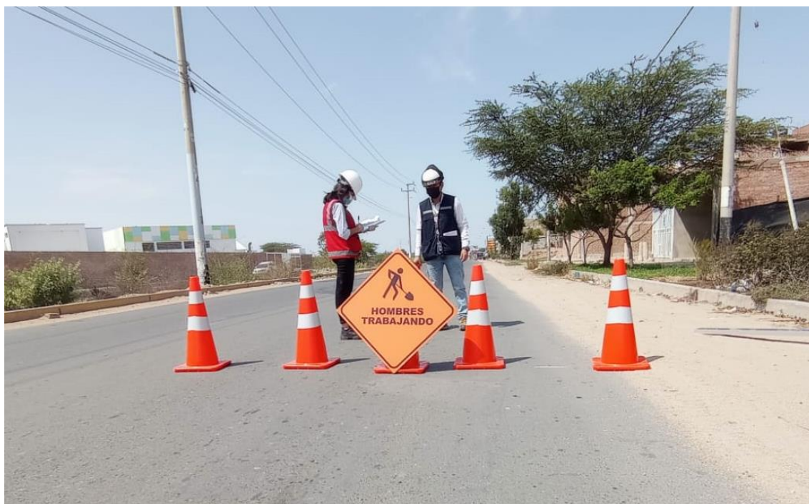
Imagen n°01- Equipos de protección colectiva para la evaluación de la vía.
