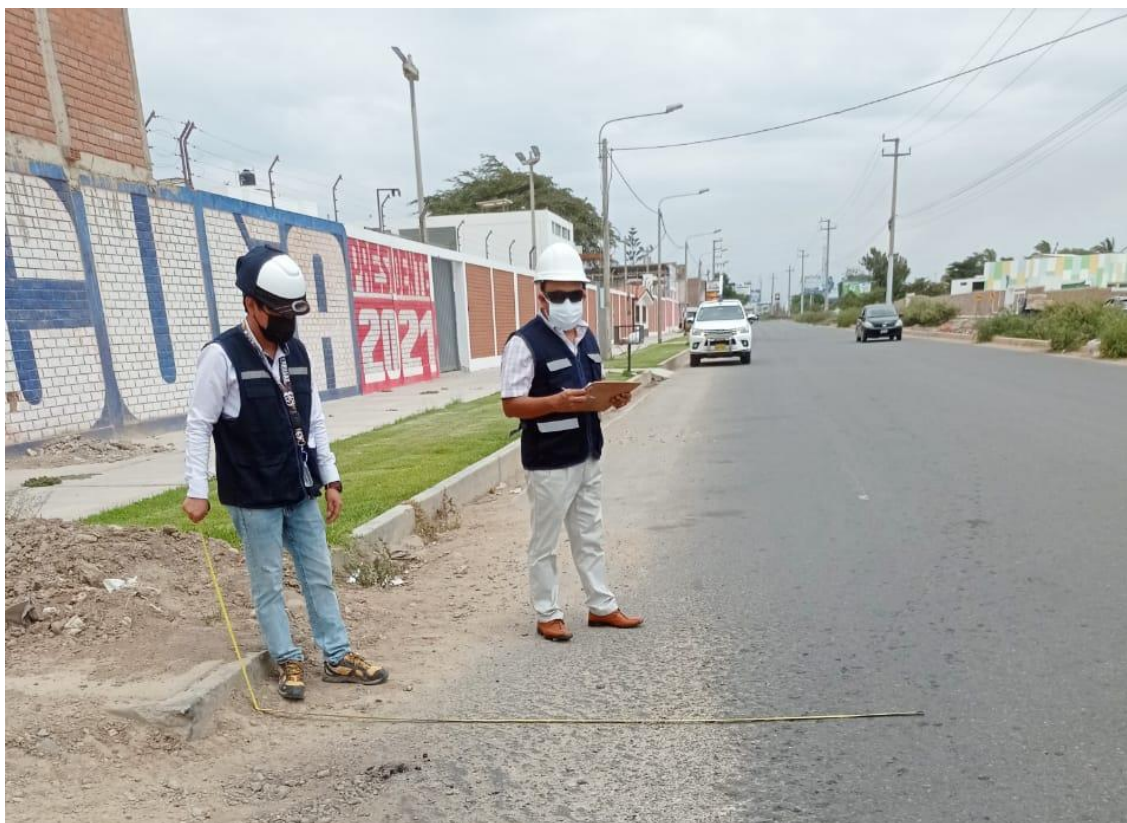
Imagen n°04- Identificación de fallas PL-Calzada Margen Derecha.
