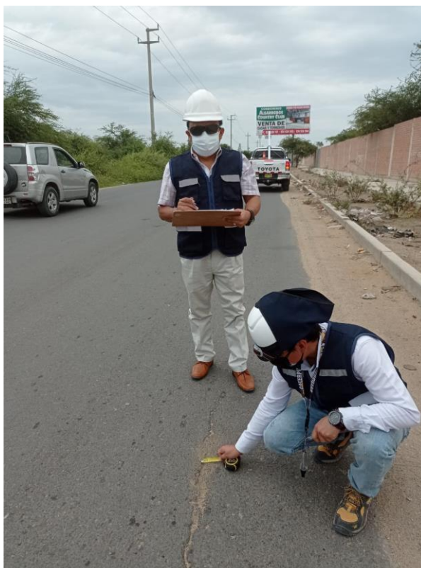
Imagen n°05- Identificación de fallas FLF-Calzada Margen Derecha.
