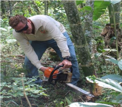
Foto 27. Corte del bambú al nivel del suelo
