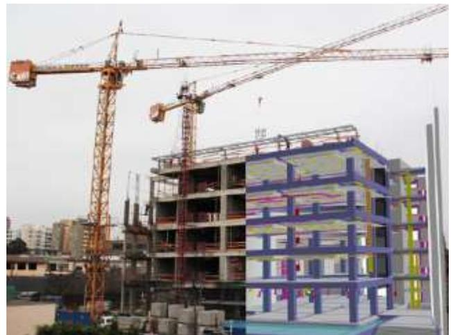
Figura 2. Representación virtual tridimensional mediante el uso del BIM. Fuente: Proyecto Universidad del Pacífico – Graña y Montero.
