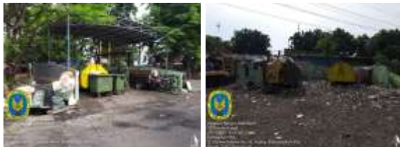
Gambar 4. TPS yang memiliki atap dan tidak
