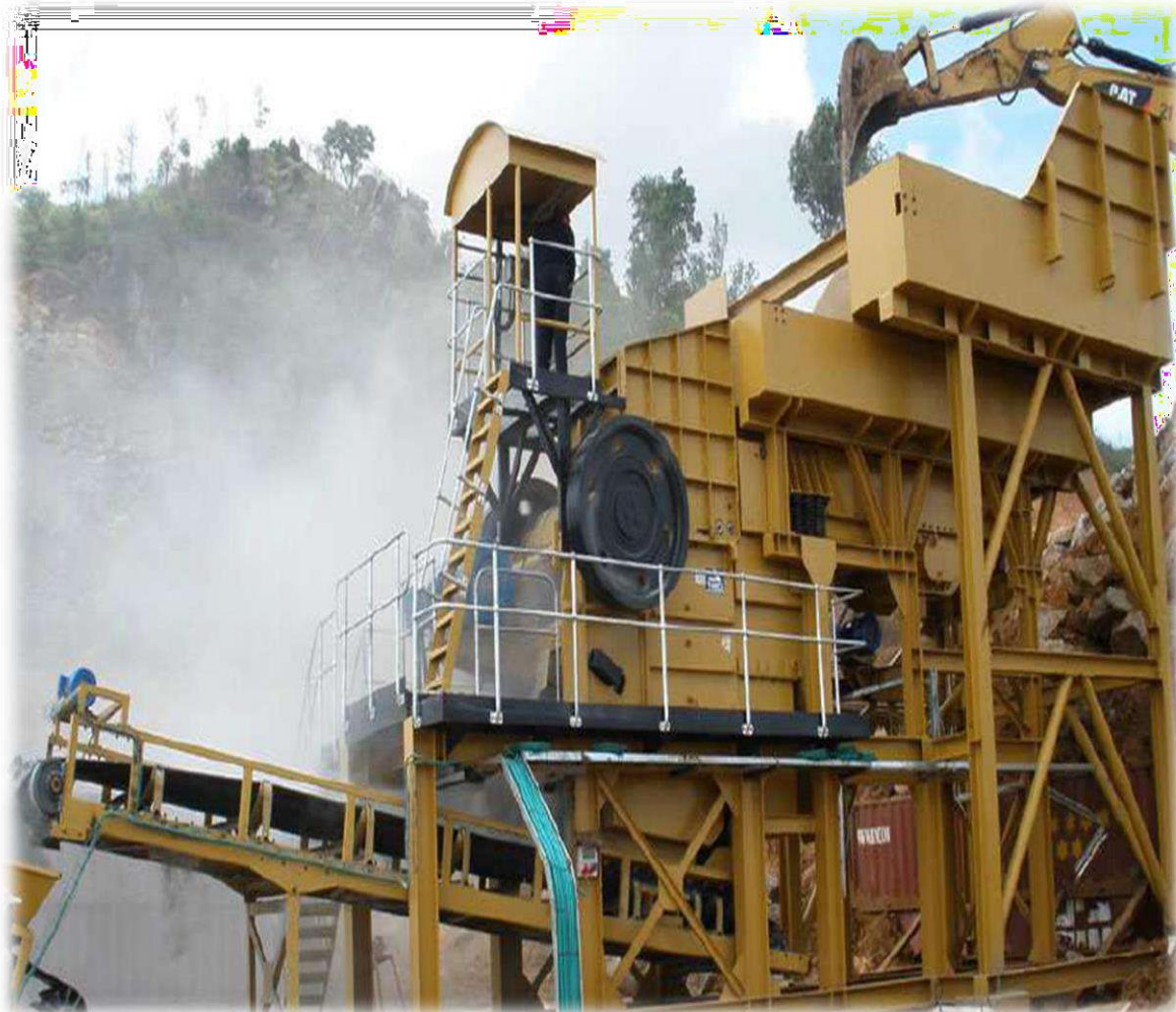
Figura 21. Vista pruebas módulo de chancado, sistema compacto. Fuente: Empresa en estudio.
