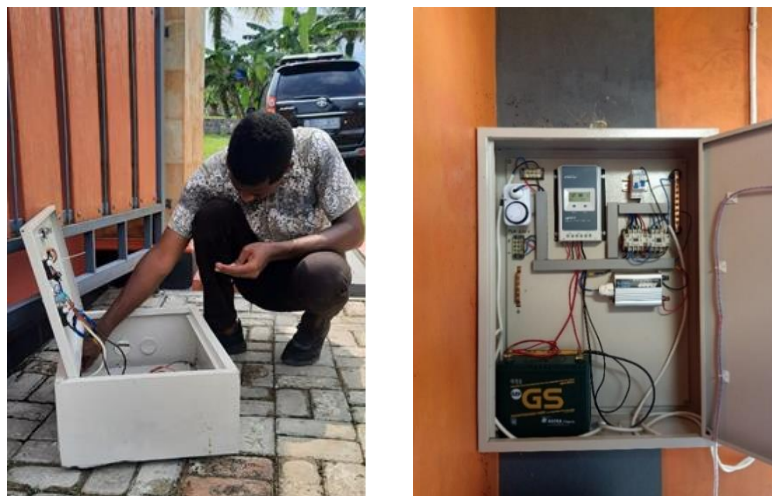
Gambar 3. Proses perakitan box panel inverter dan controller
