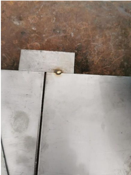
Figura 18: Fijación de las planchas
