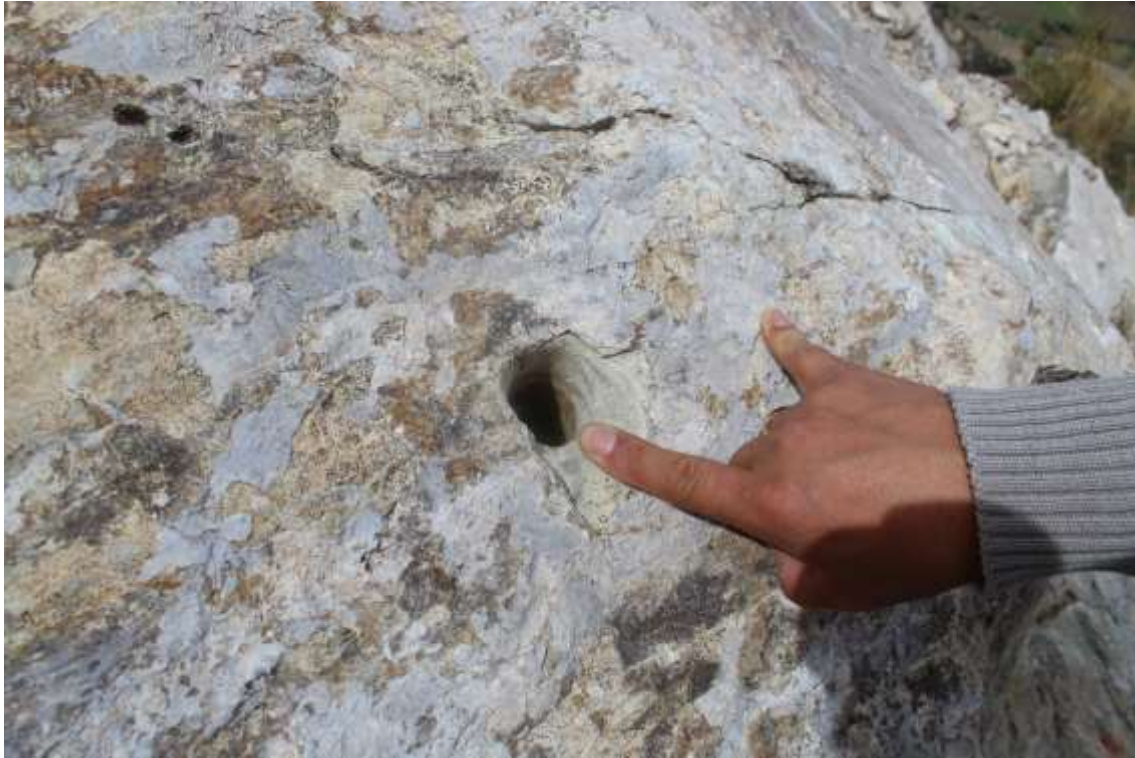
Fotografía 30. Vista mostrando un perforación diamantina para realizar voladura de la roca.
