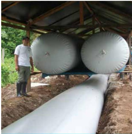
Biodigester tubular - Tocache, San Martín.
