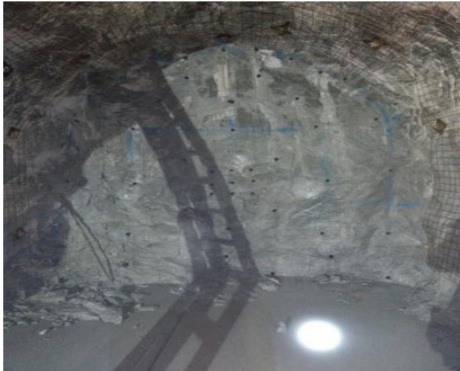
Foto 3.05 Taladros de alivio y taladros a ser cargados en la corona
