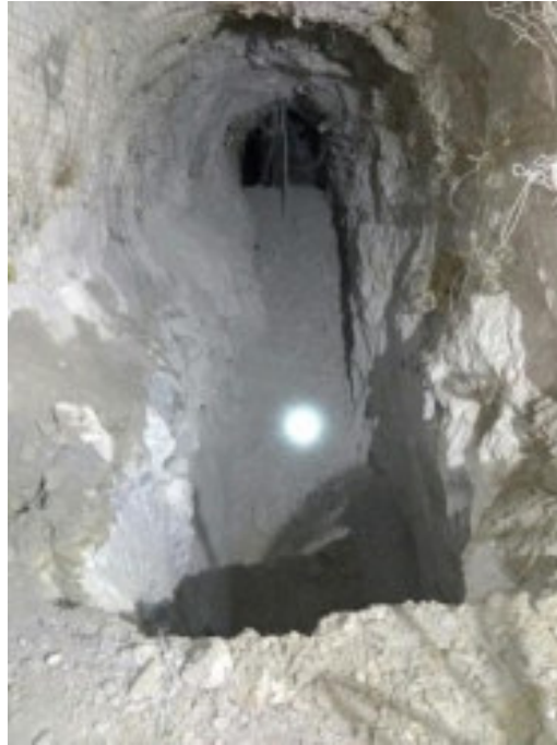
Foto 3.08 Perforación en secciones
