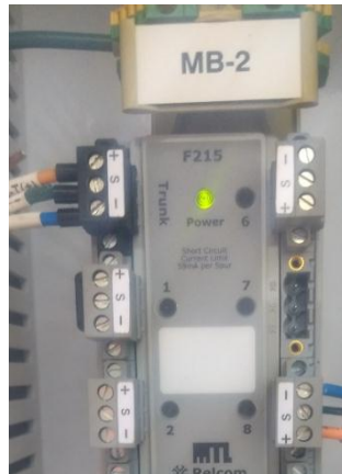
Figura 77: Conexión de Megablock MB-2
