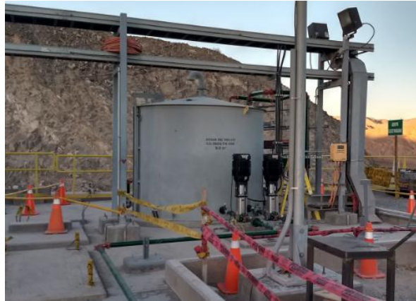
Figura 13: Sistema de Agua de Sello SMCV-Linga
