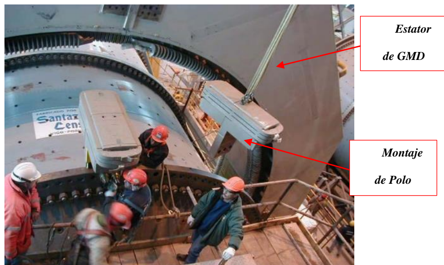
Figura 24. Instalación de Polos en brida de molino - Instalación [16]
