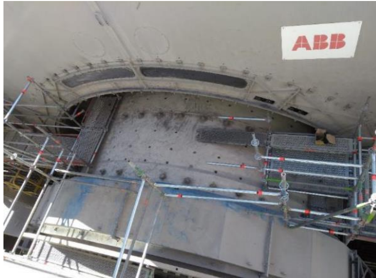
Figura 88. Acceso temporal de andamios normados [15]
