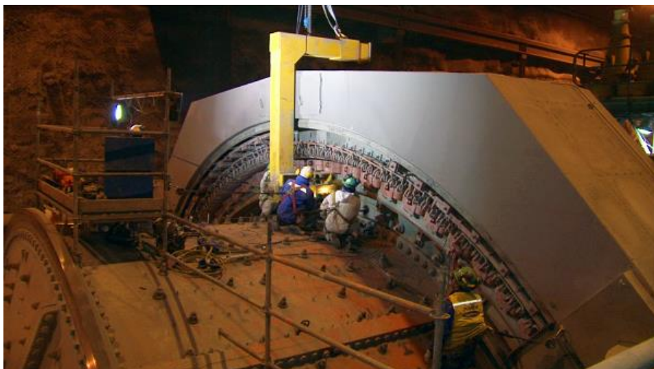
Figura 26. Cambio de Polo con herramienta C-Frame [7]
