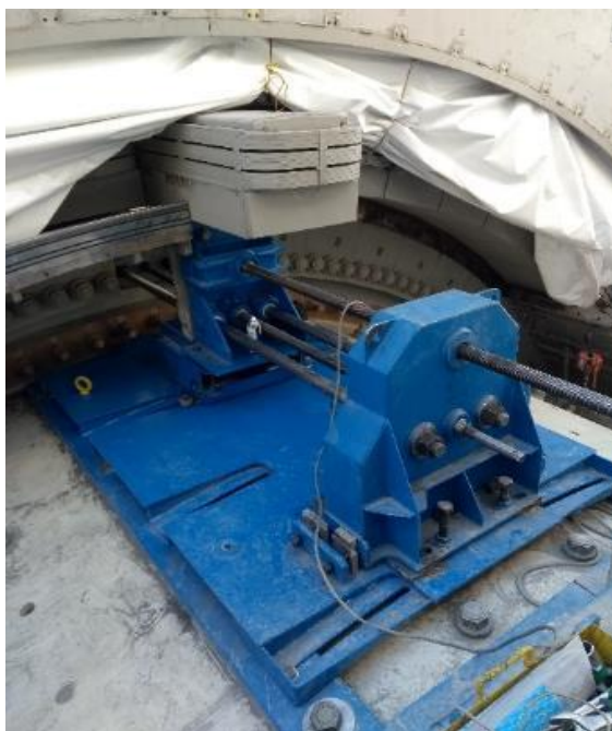
Figura 103. Extracción de polo con dispositivo [15]
