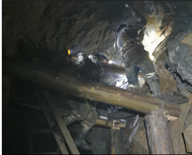
Figura 3.23: Instalación de cuadro cojo para galería Nv.4790
