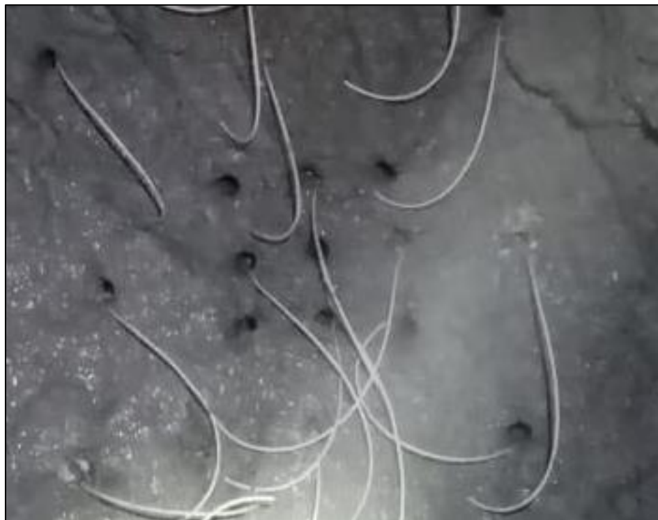
Figura 2.10: Arranque con corte quemado. Sección de 7'x7'
