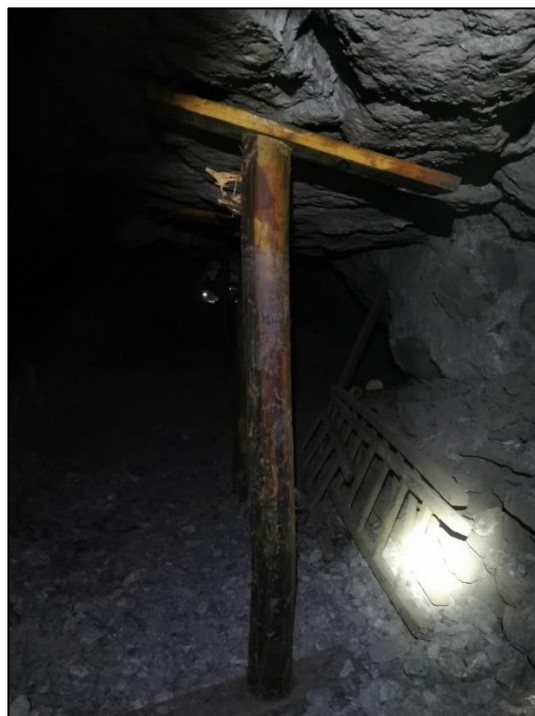
Figura 3.24: Sostenimiento con puntal con plantilla para tajo.
