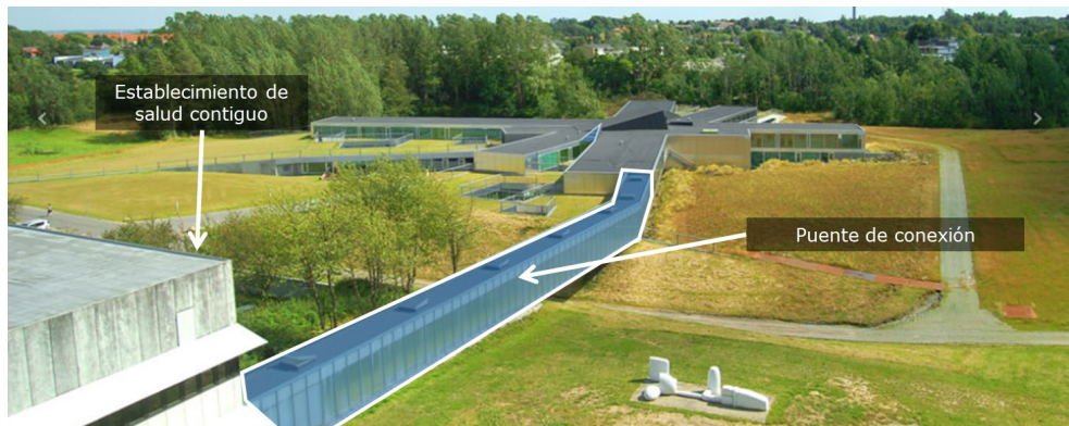
Figura 31. Puente de conexión HP Helsingor. FUENTE: Elaboración propia
