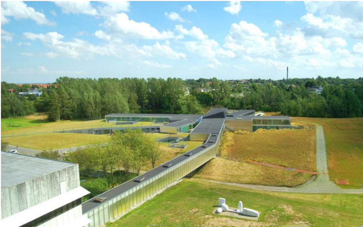
Figura 20. Vista exterior Hospital Psiquiátrico Helsingor en Dinamarca. FUENTE: JDS Architects 2016
