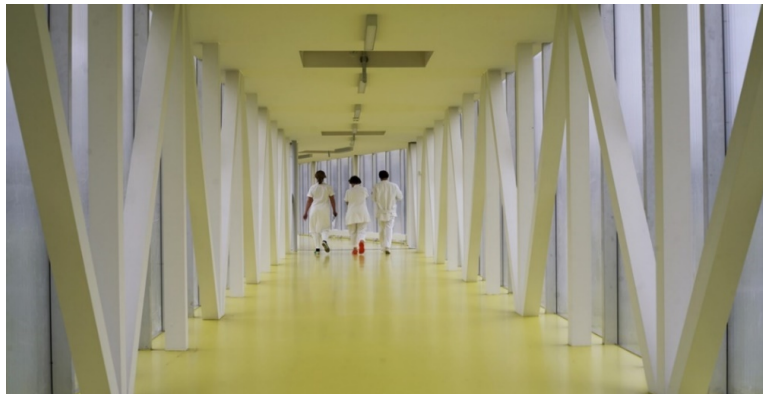
Figura 35. Vista interior del Puente de conexión con el H.P. Helsingor.
