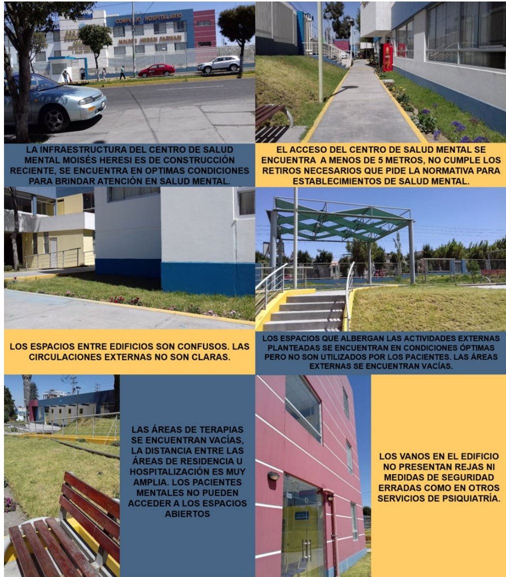
Figura 110. Evaluación del Estado de la construcción del CSM Moisés Heresi. FUENTE: Elaboración propia
