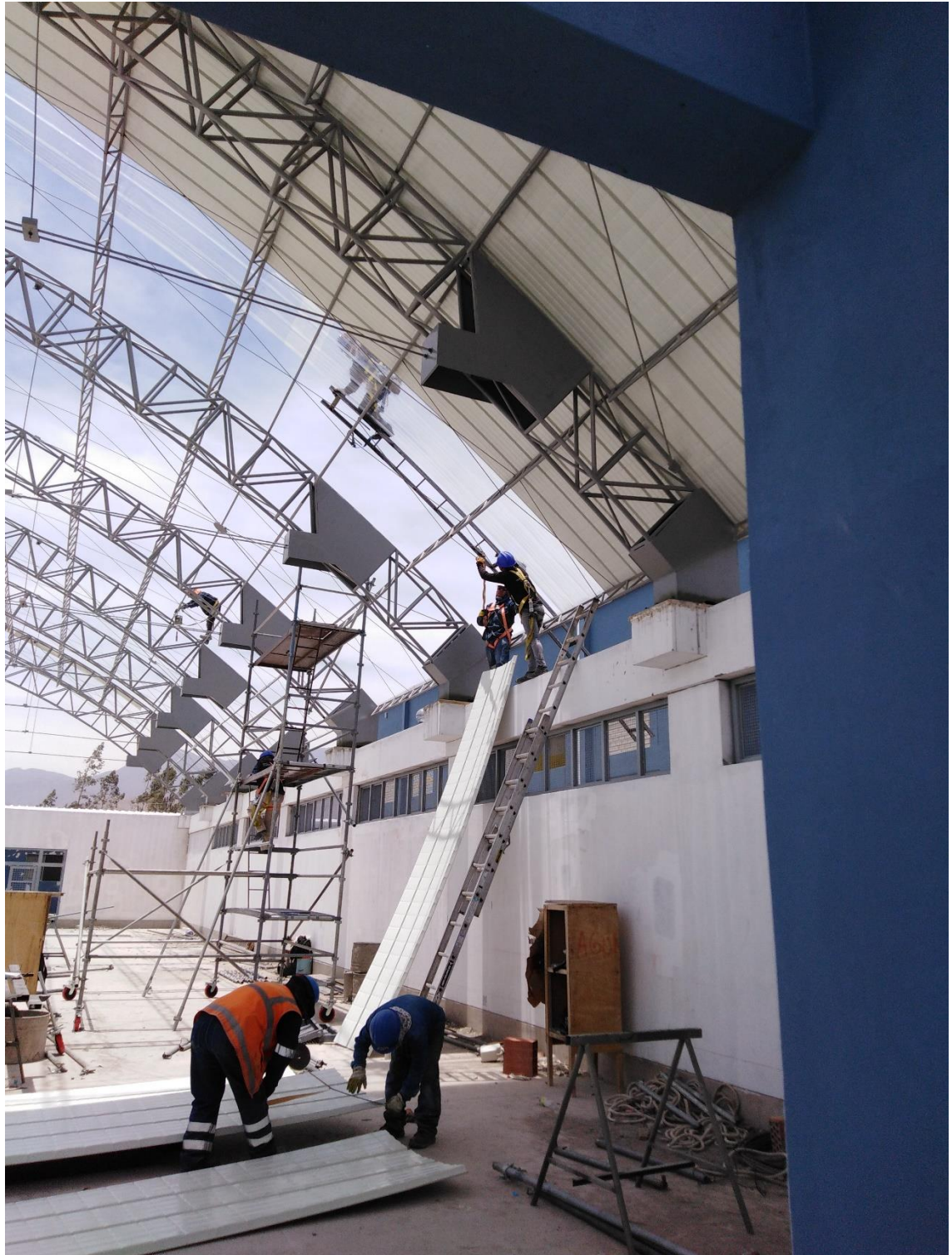
Figura 5.51 Instalación de cubiertas metálicas en Polideportivo.
