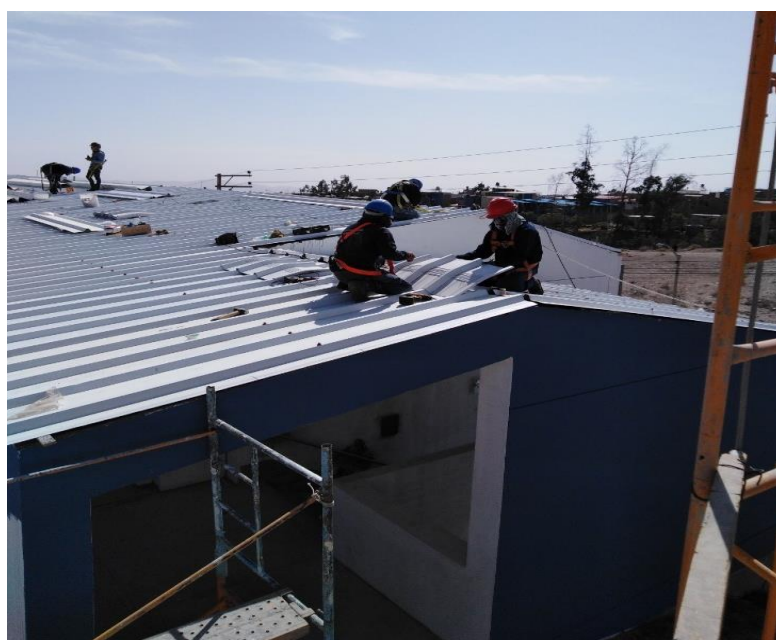
Figura 5.46 Instalación de cubiertas metálicas en pabellón N°1 cumbreiras.
