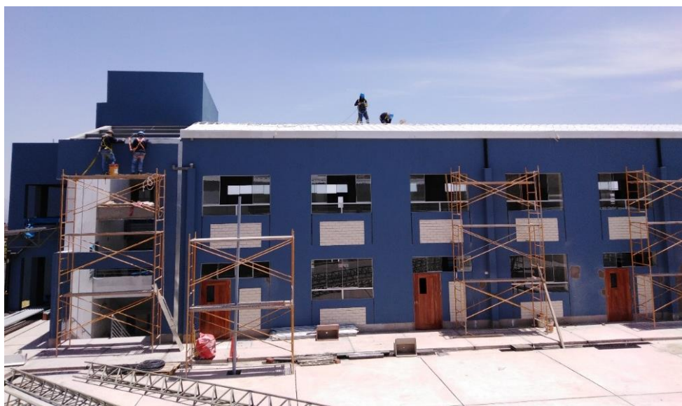
Figura 4.88 Instalación de Paneles I.E. DEAN VALDIVIA Pabellón 2.
