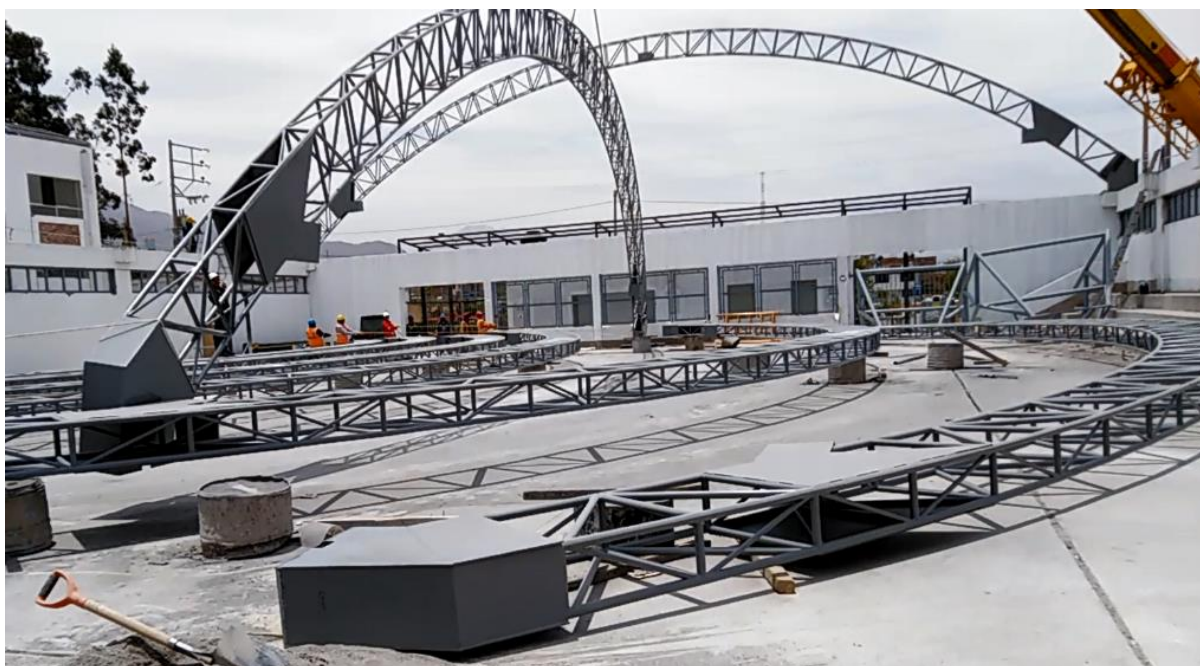
Figura 5.35 Izaje de arcos metálicos.
