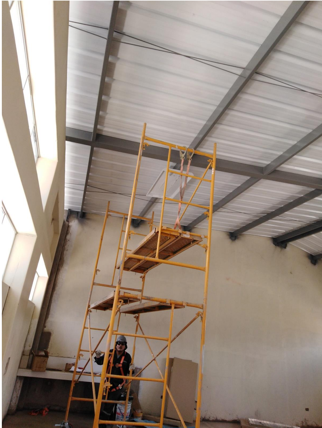
Figura 5.49 Instalación de cubiertas metálicas en pabellón N°2 interior.
