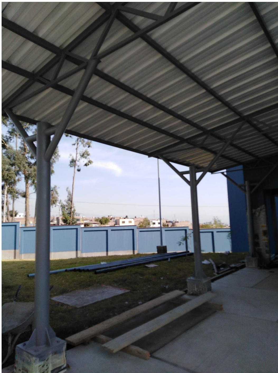
Figura 5.50 Instalación de cubiertas metálicas en Pérgola.
