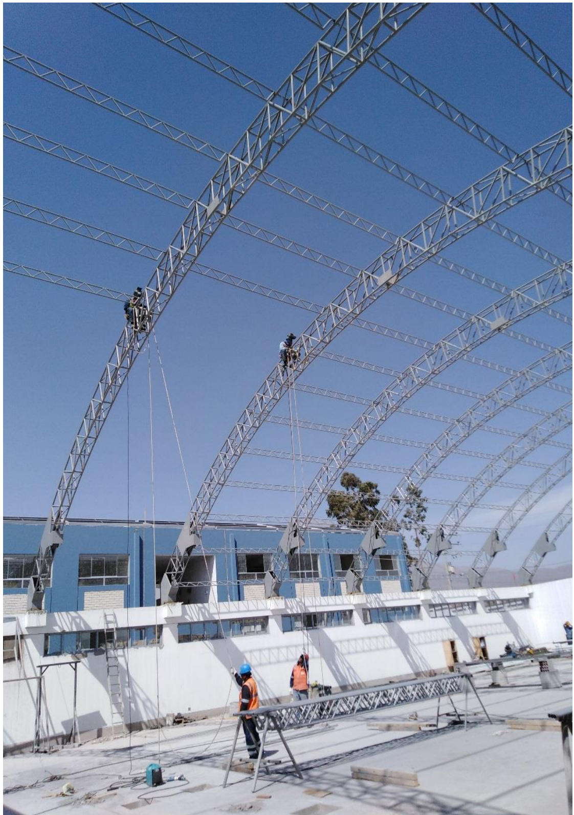
Figura 5.44 Vista final de los arcos del polideportivo.
