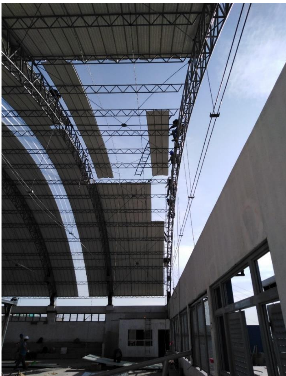
Figura 4.87 Instalación de Paneles I.E. DEAN VALDIVIA-Polideportivo.
