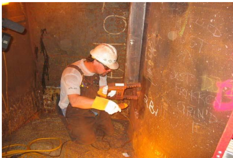
Figura 4.47 Inspección por Partículas Magnéticas de la junta soldada.
