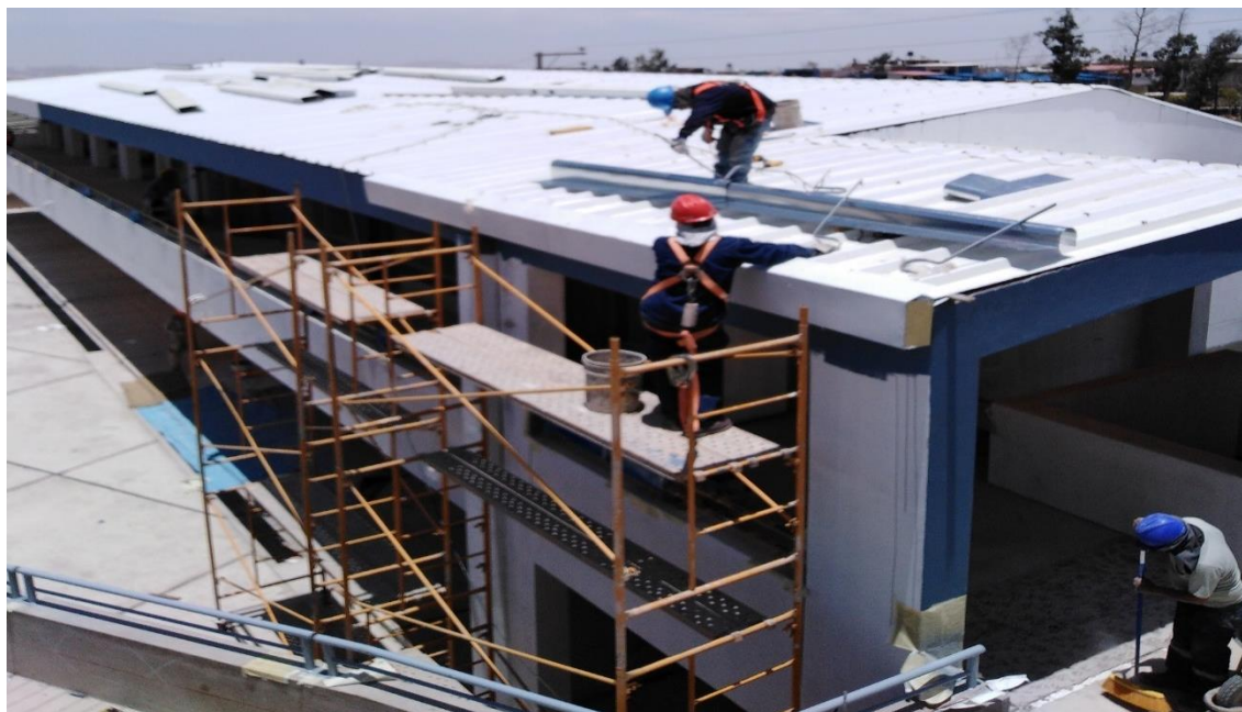
Figura 5.47 Instalación de cubiertas metálicas en pabellón N°1.
