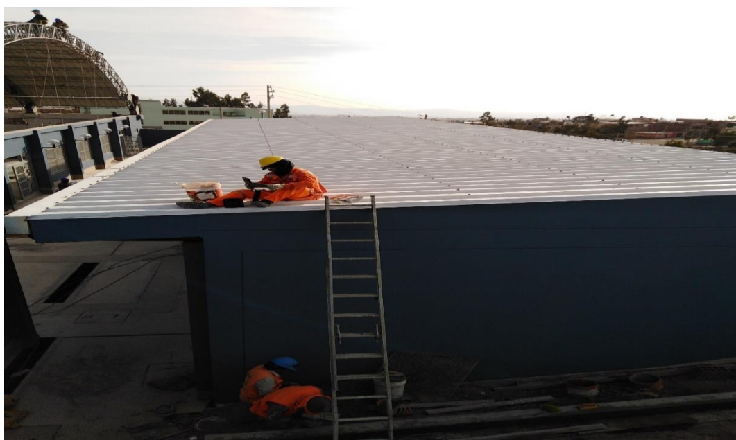
Figura 5.48 Instalación de cubiertas metálicas en pabellón N°2.
