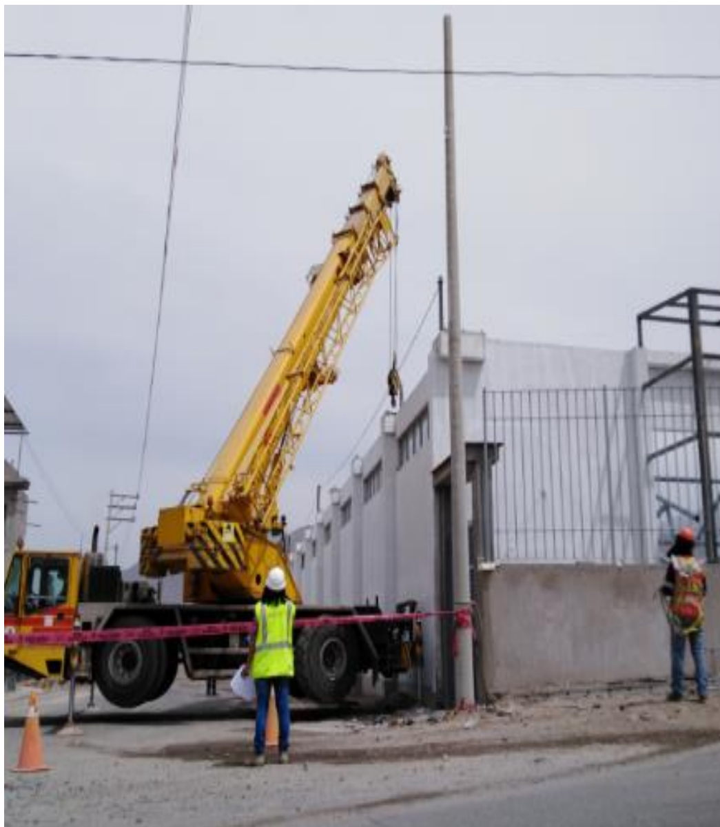
Figura 5.36 Grúa usada para el izaje.
