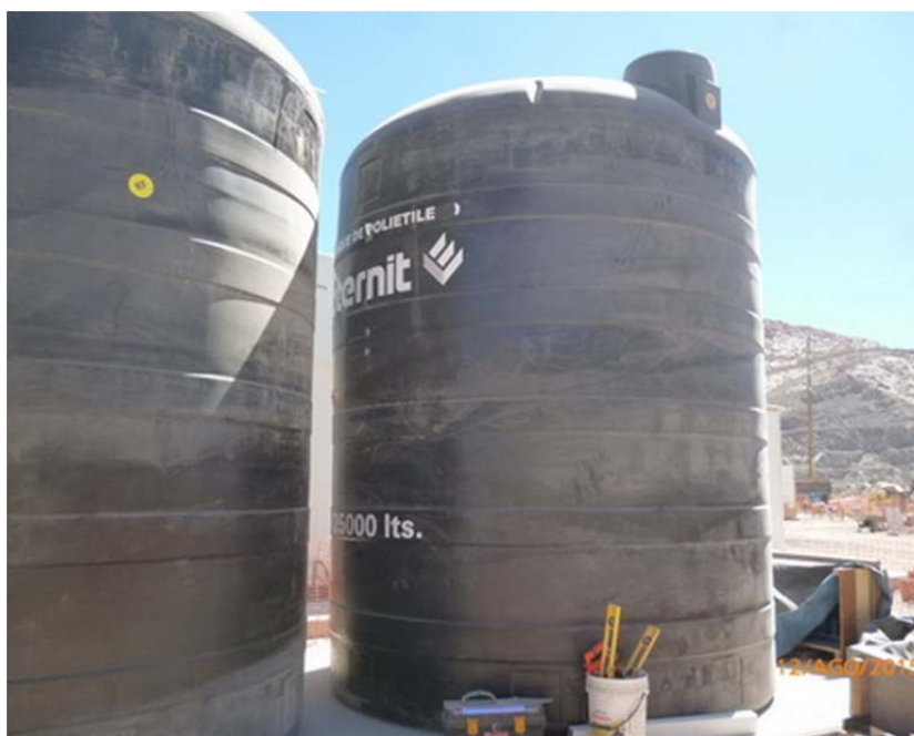
Fig. 29- Instalación de tanques de almacenamiento en facilidades Linga .
