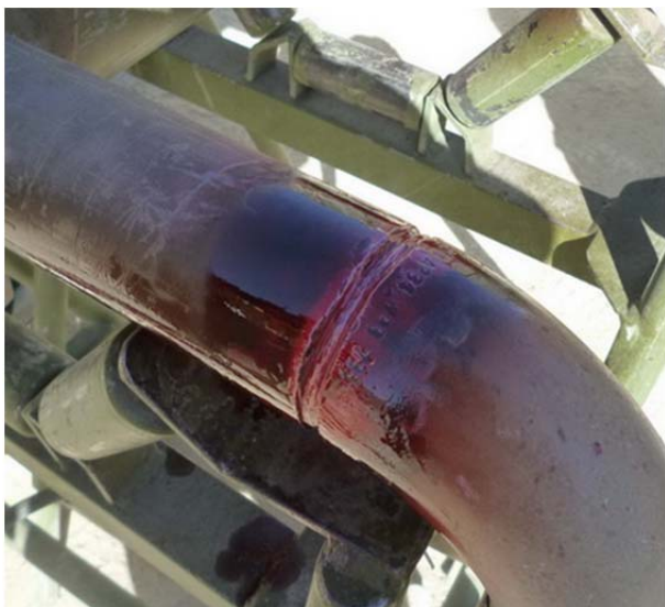
Fig. 22- Aplicación de PT a juntas sold. de tuberías.
