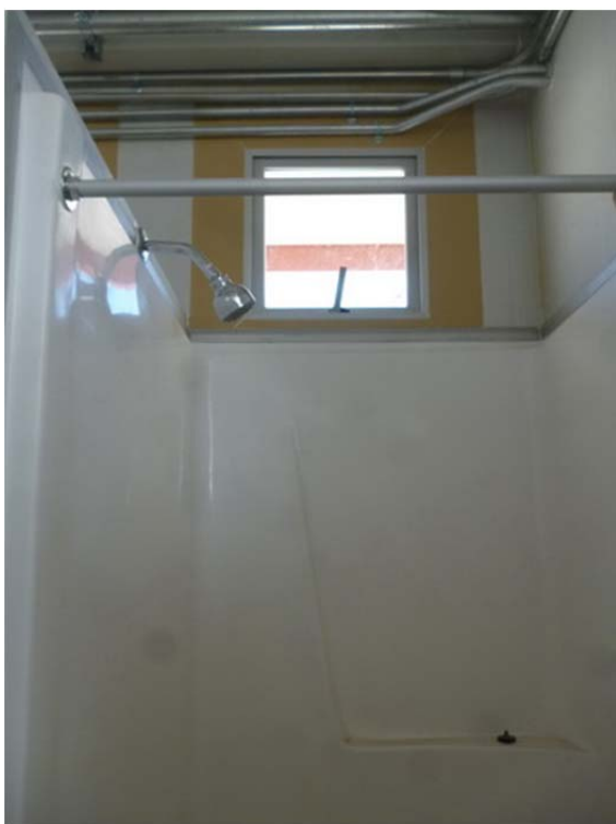
Fig. 52- Pruebas de aparatos sanitarios (duchas).
