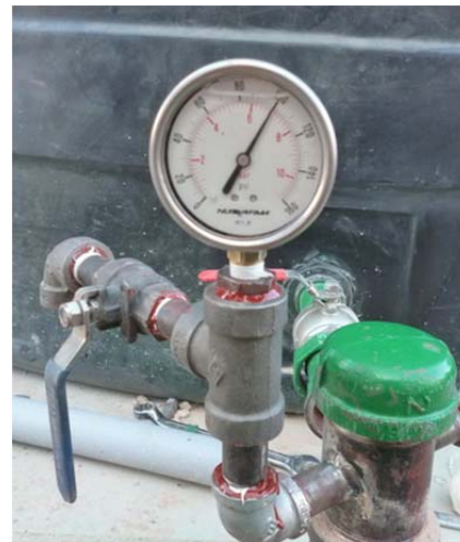
Fig. 44- Prueba de presión de tuberías.
