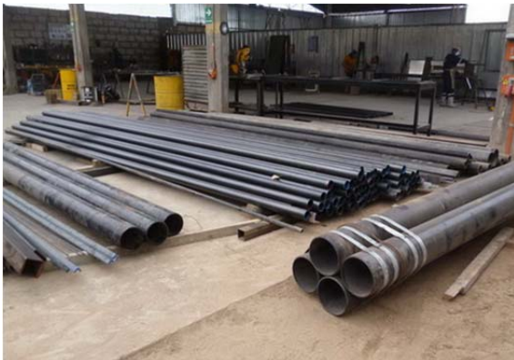
Fig. 15- Recepción de tuberías.
