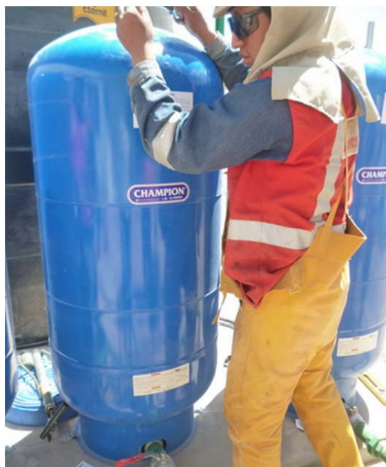
Fig. 31- Instalación de los tanques hidroneumáticos.
