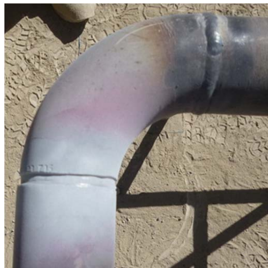
Fig. 23- Aplicación de PT a juntas sold. de tuberías.
