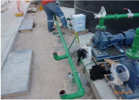
Fig. 41- Flushing de tuberías.
