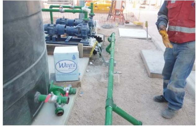
Fig. 42- Flushing limpieza de tuberías.
