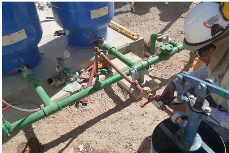
Fig. 43- Prueba de presión en tuberías.
