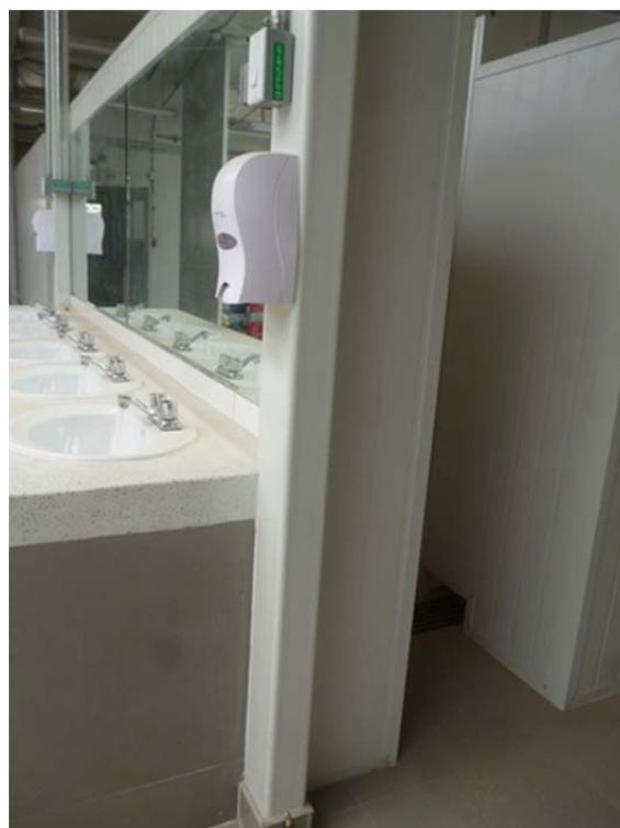
Fig. 53- Pruebas de aparatos sanitarios (lavamanos).
