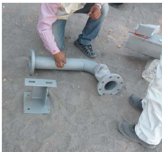
Fig. 24- Preparación superficial de tuberías.
