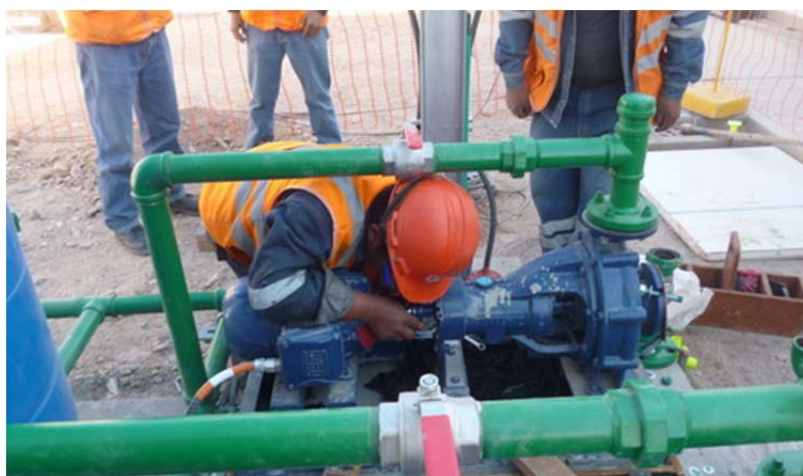
Fig. 36- Verificación de alineamiento de las unidades de bombeo de facilidades Linga .
