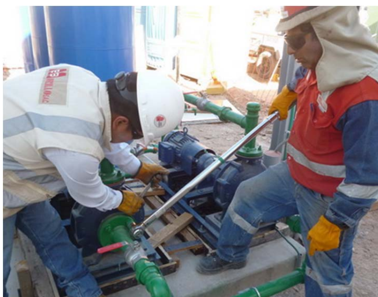
Fig. 30- Ajuste y torqueo de las unidades de bombeo.
