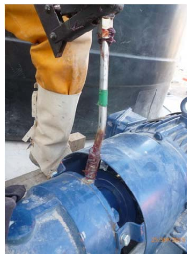
Fig. 38- Engrase de rodamientos.
