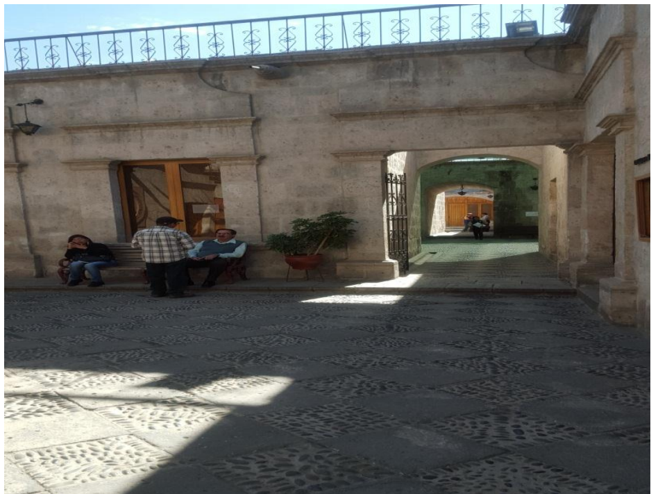
Figura 34: Patio – Zona Segura N° 02
