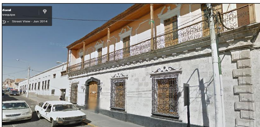
Figura 6: Frentera Puerta Ingreso Calle Moral
