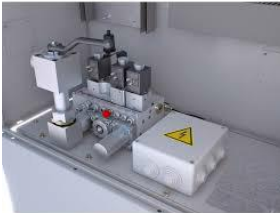
Imagen 9. Control de velocidad de un ascensor.
