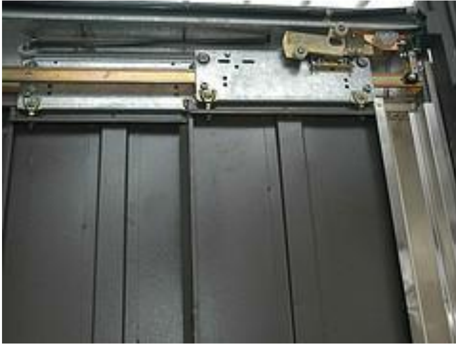
Imagen 10. Vista de una puerta de elevador. Fuente: (Garcia , 2016)
