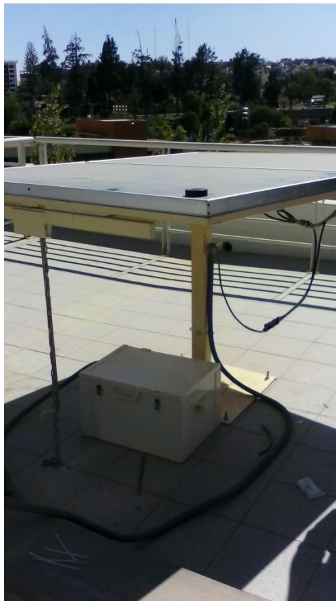
Figura 45 Bastidor Instalado
