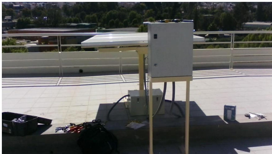
Figura 48 Soporte de tablero instalado.
