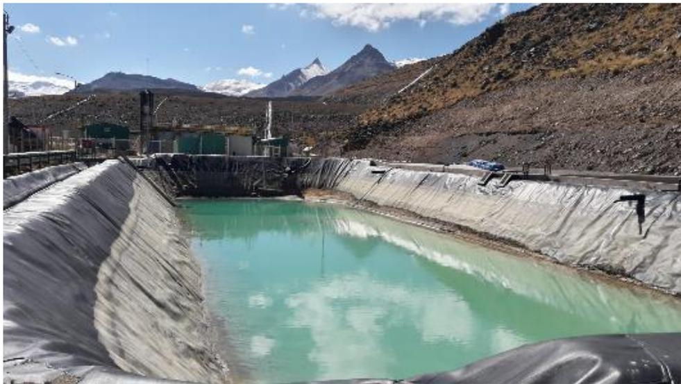
IMAGEN N° 3.4: Poza de Clarificación vista hacia recepción de solución de planta PTARE
