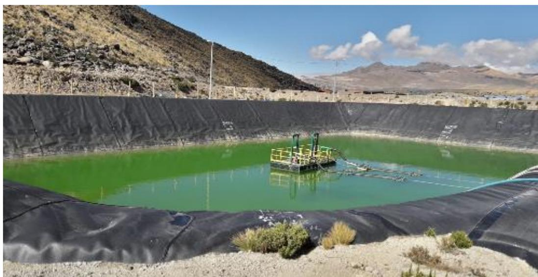
IMAGEN N° 3.6: Poza de Amortiguamiento (balsa de bombeo de solución recuperada hacia vertimiento y riego) Fuente: Elaboración Propia
