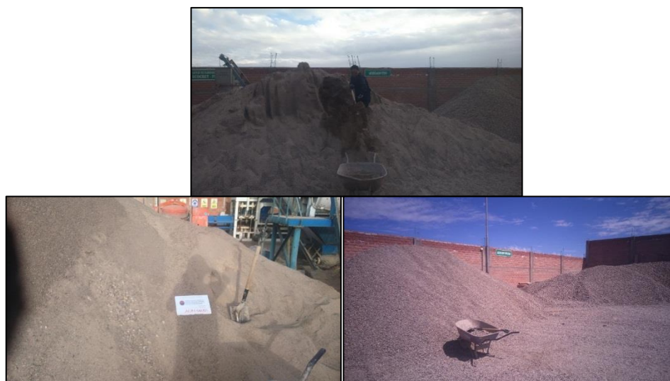
Figura 2-2 Acopios de agregados fino y grueso
