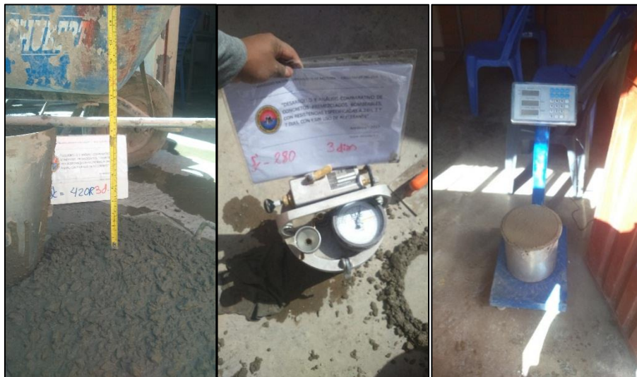
Figura 5-4 pruebas de ensayos de revenimiento, porcentaje de aire y peso unitario del concreto fresco
