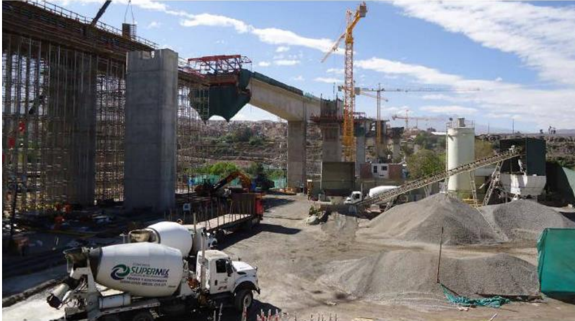
Figura 1-6 Construcción del puente Chilina
