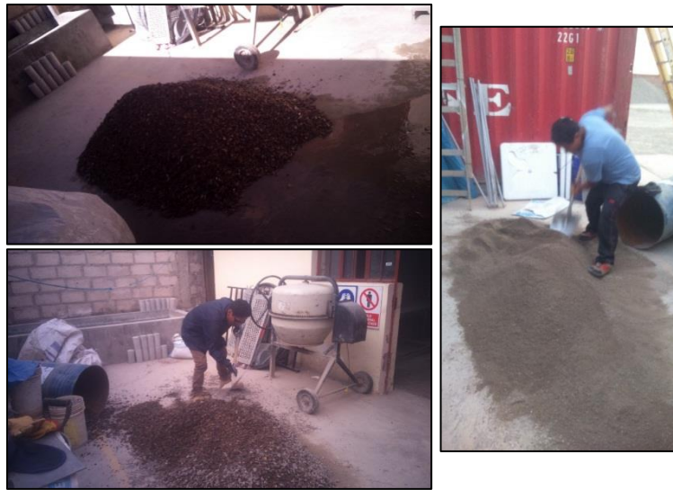
Figura 4-7 Preparación y homogenización de los agregados
