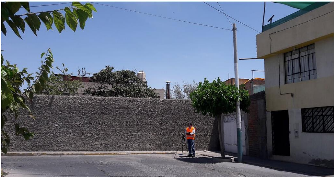
Foto N° 17: Instalación del sonómetro en el Punto 8.
