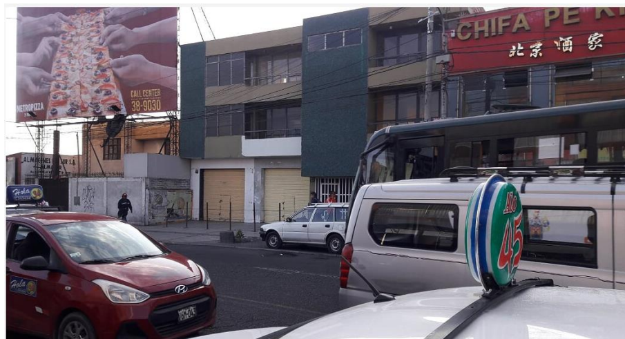
Foto N°1: Punto de monitoreo 1.
