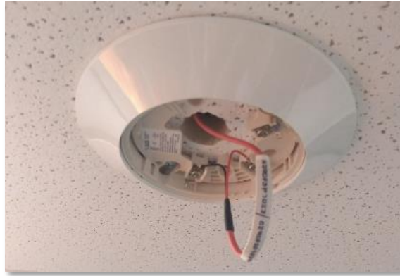
Figura 5.6. Identificación de Conductores FLP
