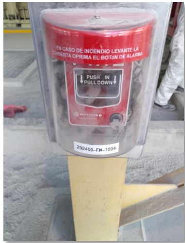
Figura 4.21. Instalación de Estaciones Manuales con Cobertores
