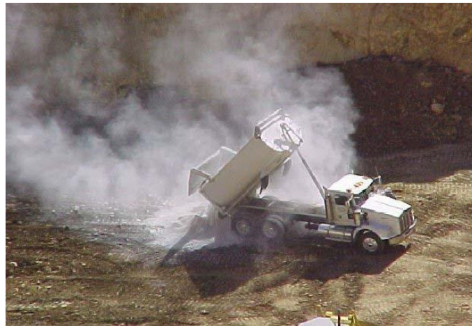
Figura N° 2.11. Adición de material alcalino.
