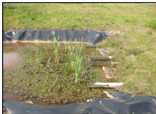
Figura N° 3.15. Balsas de oxidación y precipitación a la salida de un ALD.
