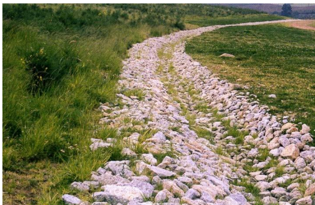
Figura N° 3.16. Circulación del agua a través de un canal revertido de caliza y construido en una escombrera restaurada.
