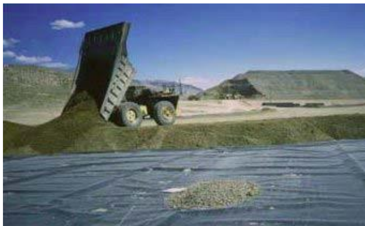
Figura N° 2.7. Sellado con láminas impermeables y suelo vegetal.
