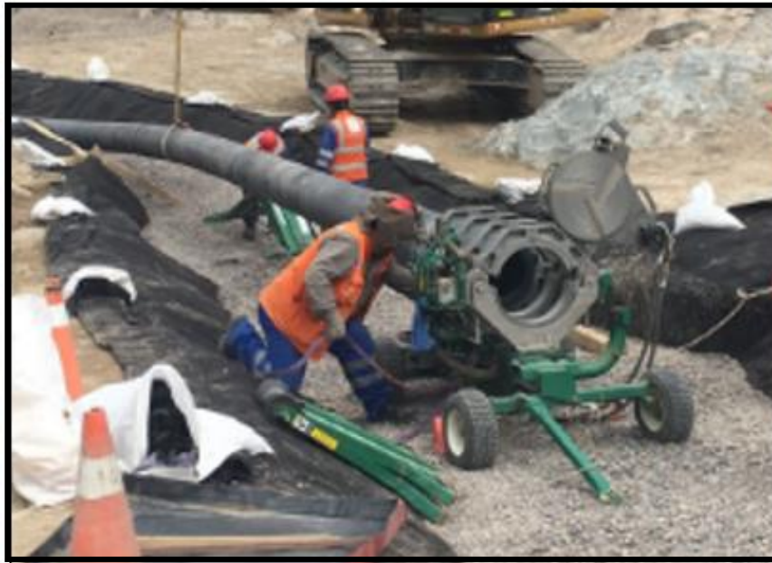
Figura 75. Montaje de tubería HDPE.
