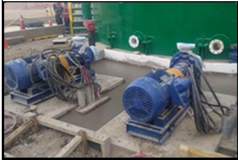
Instalación de bombas TK 2937
