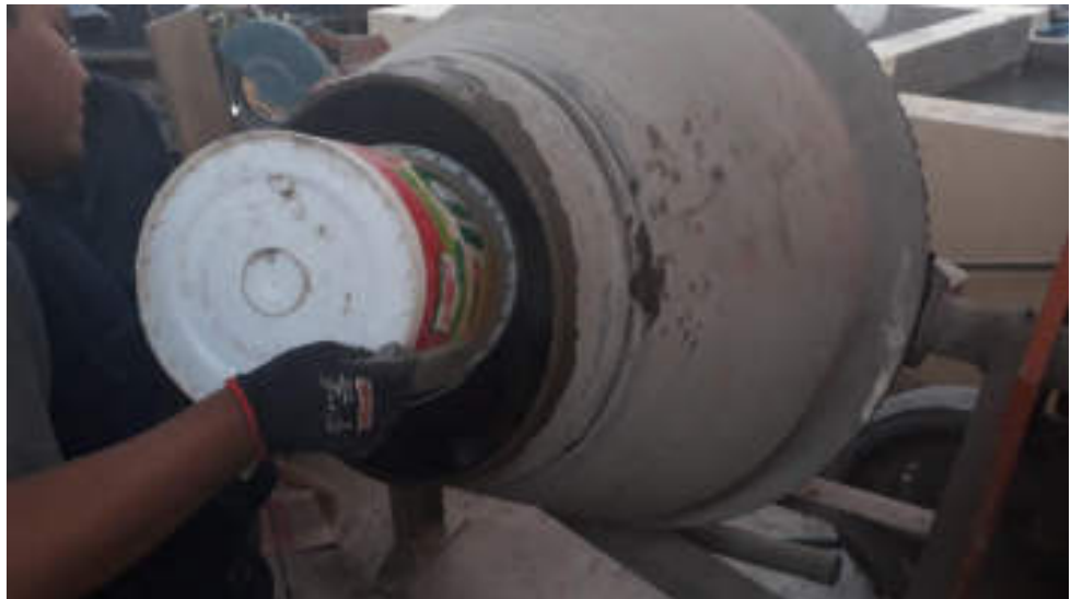
Figura 12: Añadido del cemento a la mezcla
