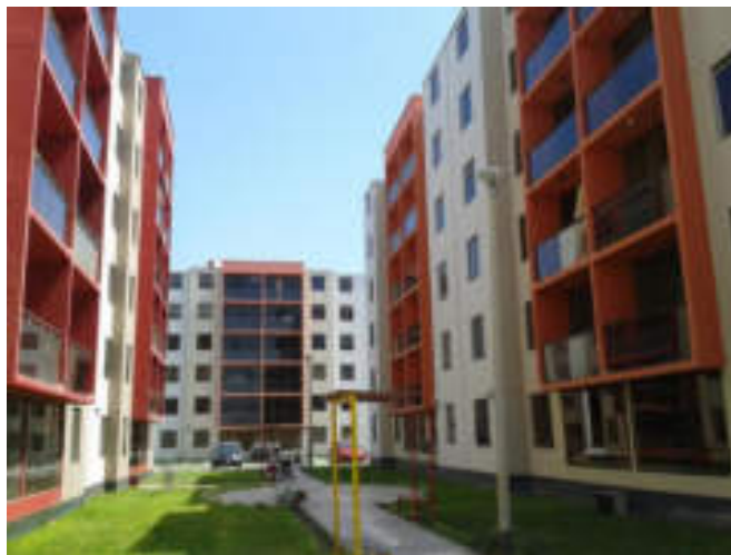
Figura 4: Edificaciones con muros de ductilidad limitada MDL en Chiclayo - Perú
