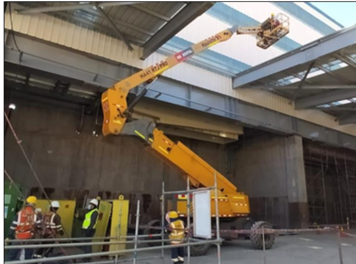
Figura 2222. Equipo manlift, ajuste de pernería.
