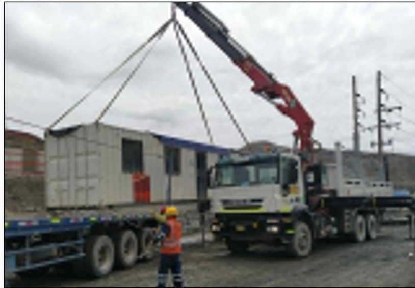
Figura 200. Camión grúa realizando trabajos de izaje.
