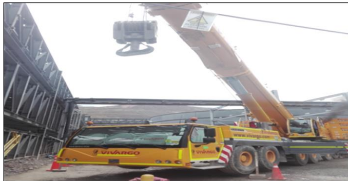
Figura 188. Grúa Telescópica, montaje de elementos estructurales. Fuente: Elaboración propia
