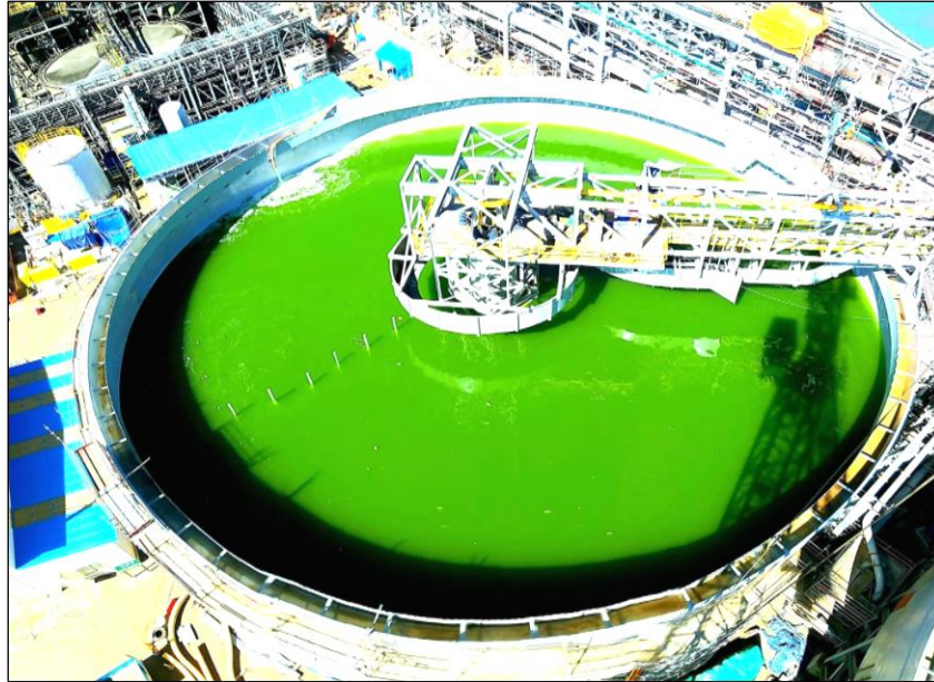
Figura 54. Prueba de Estanqueidad.
