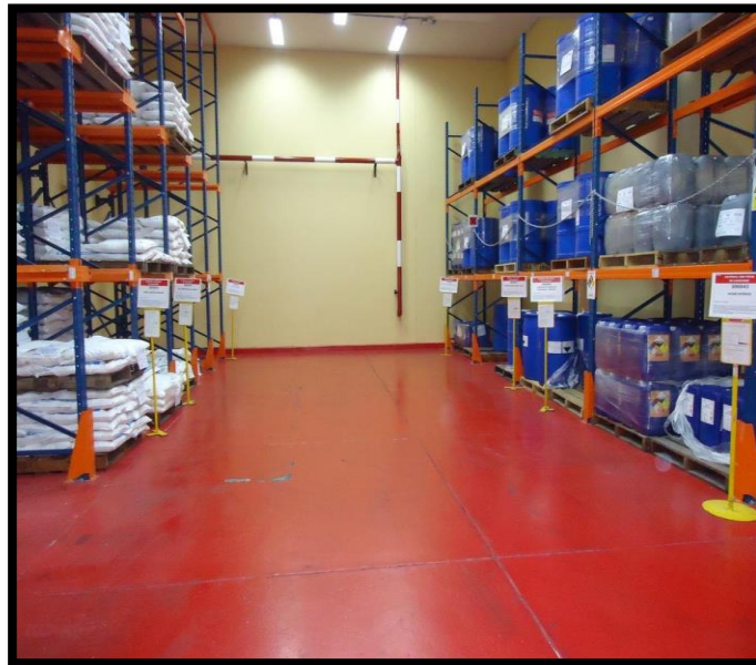
Figura 33. Piso con pintura epoxi anti derrames
