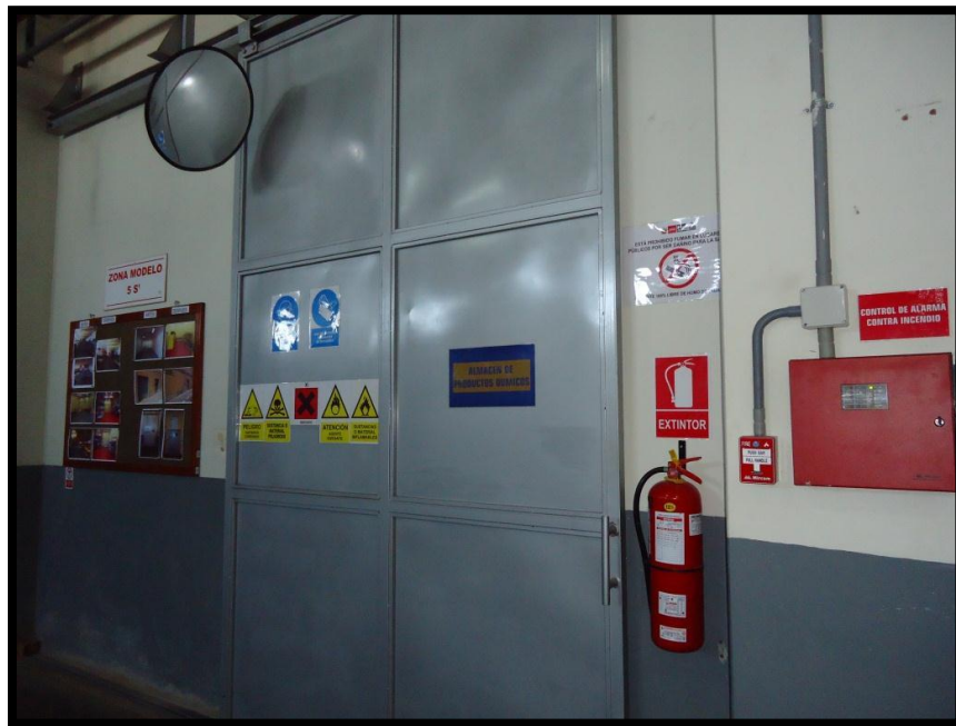
Figura 29. Puertas de seguridad
