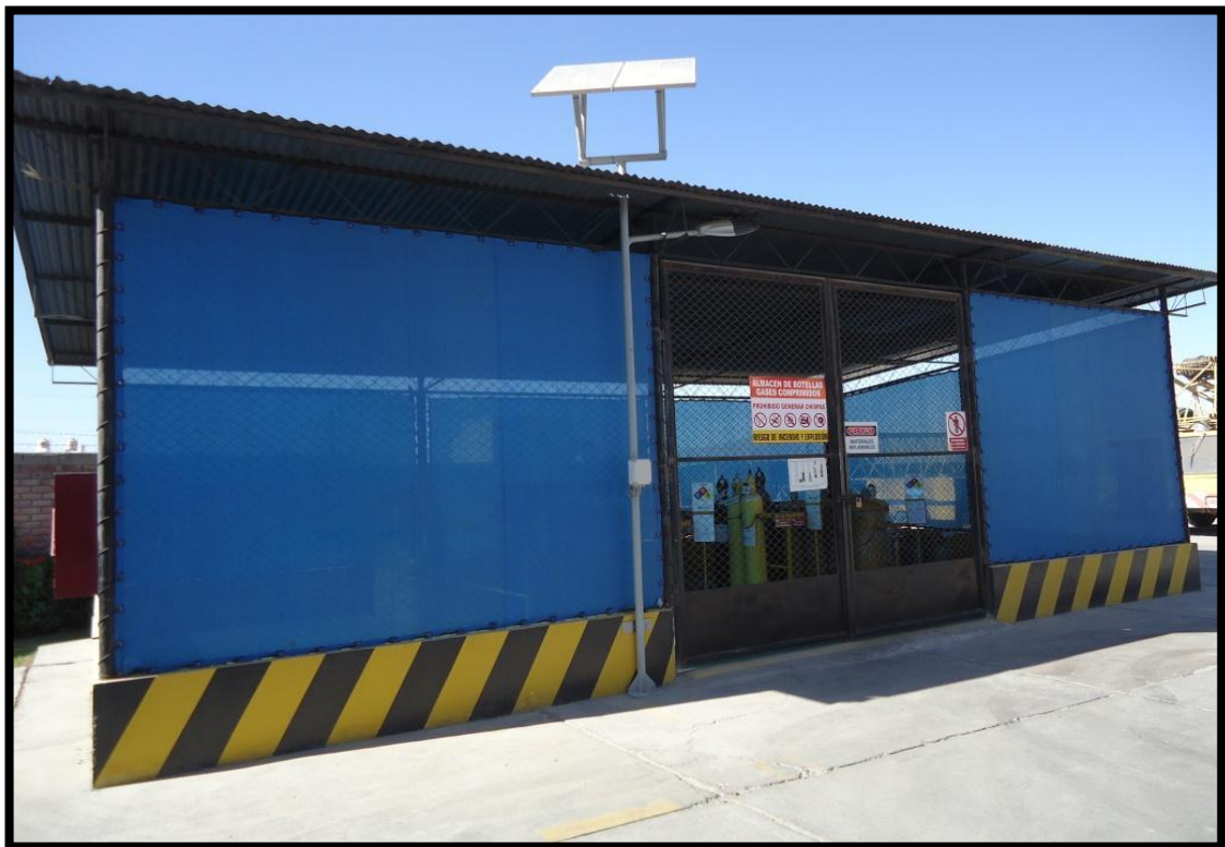
Figura 43. Almacén de gases
