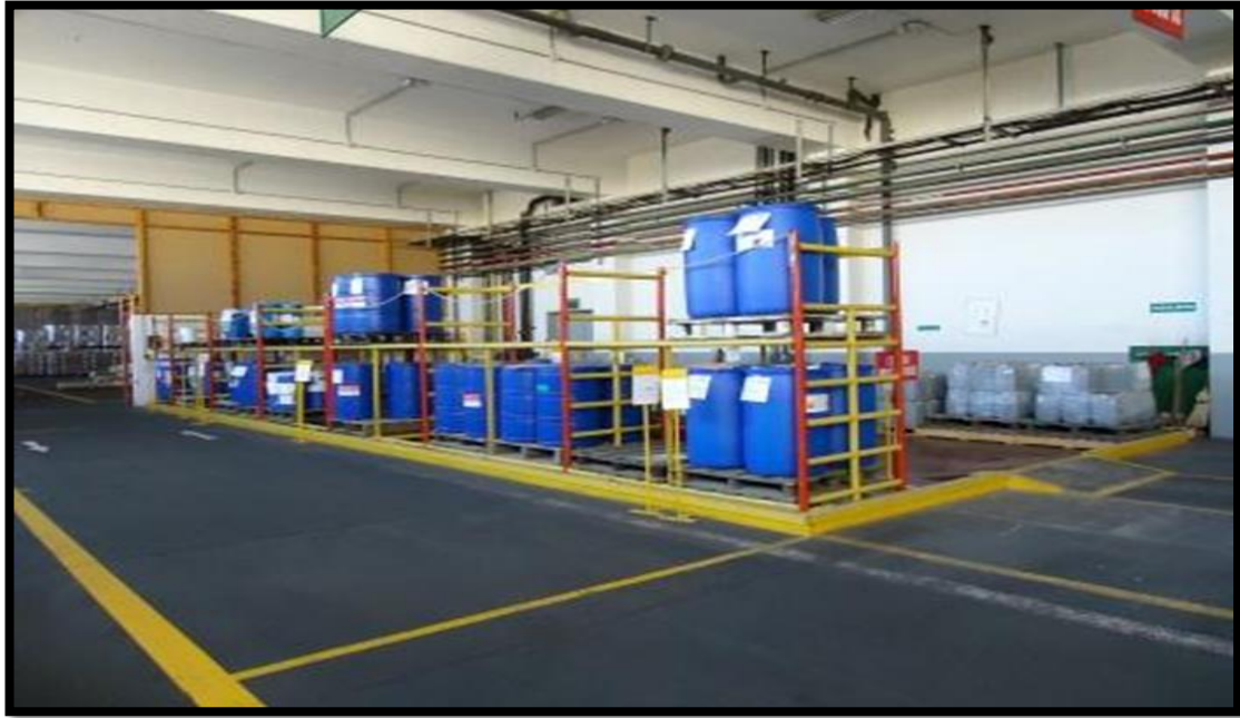
Figura 25. Almacén antes de la mejora 1
