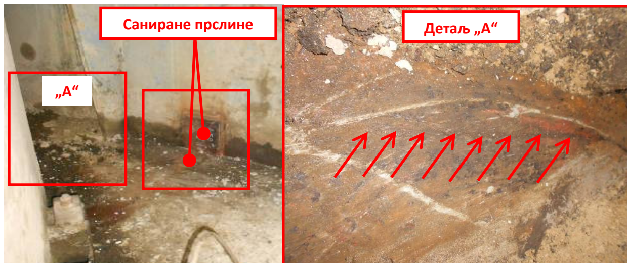
Слика 10. Постојећа прлина доње плоче
