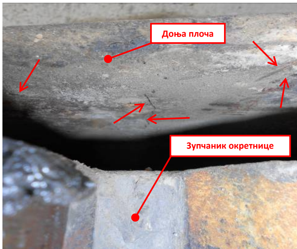
Слика 13. Доња плоча, поље 16, поглед одоздо
