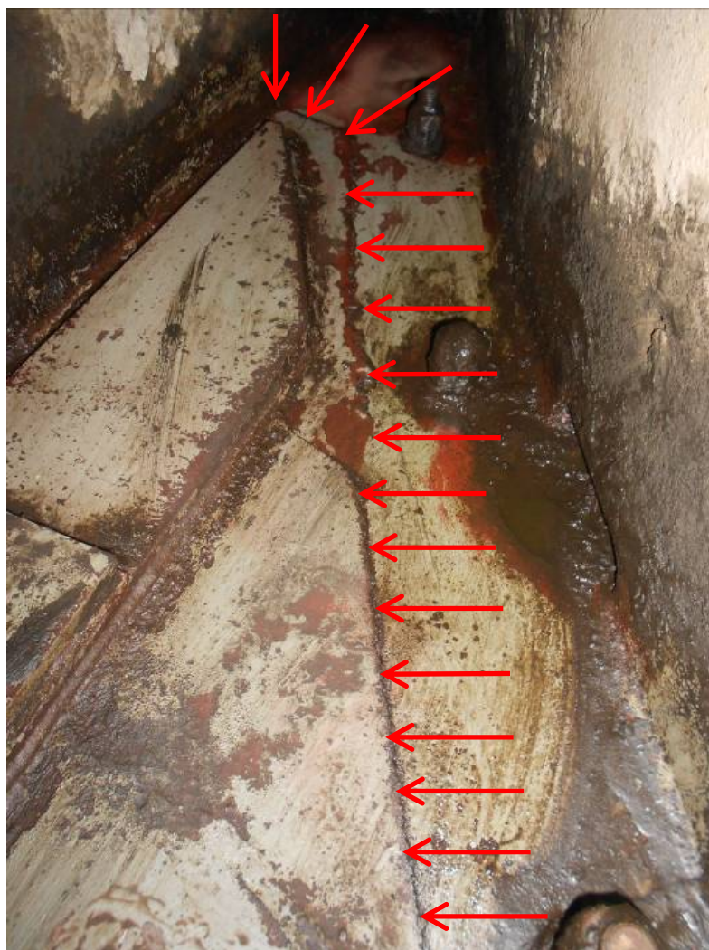
Слика 11. Пукотина на доњој плочи, поглед изнутра
