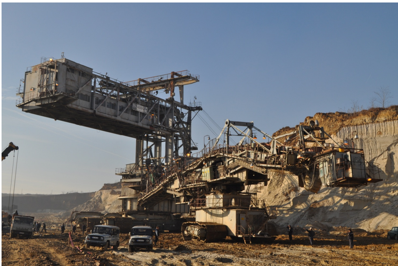
Слика 3. Кретање багера од места хаварије до ремонтног плаца (12.12. 2012.)
