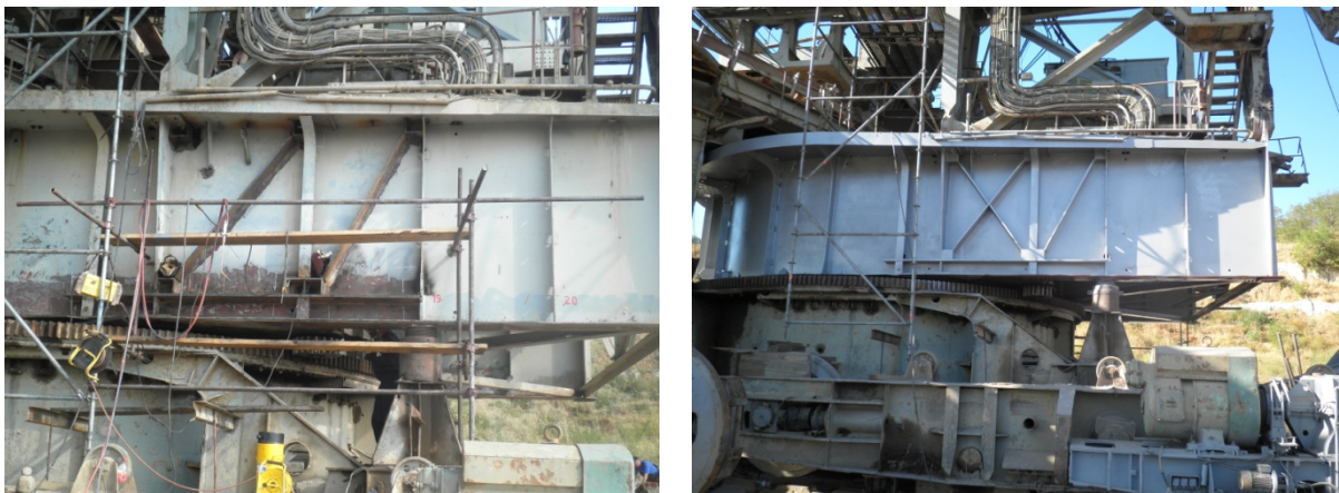
Слика 45. Санација и реконструкција обртне платформе (изглед споља)
