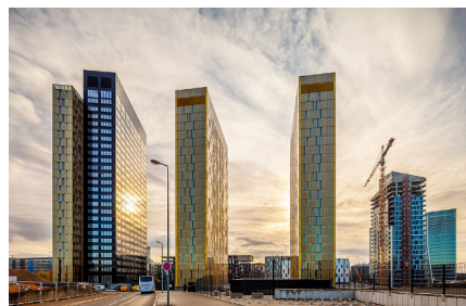
Abb. 1: Außenansicht des Gerichtshofs der Europäischen Union (Verdier 2020) 3
