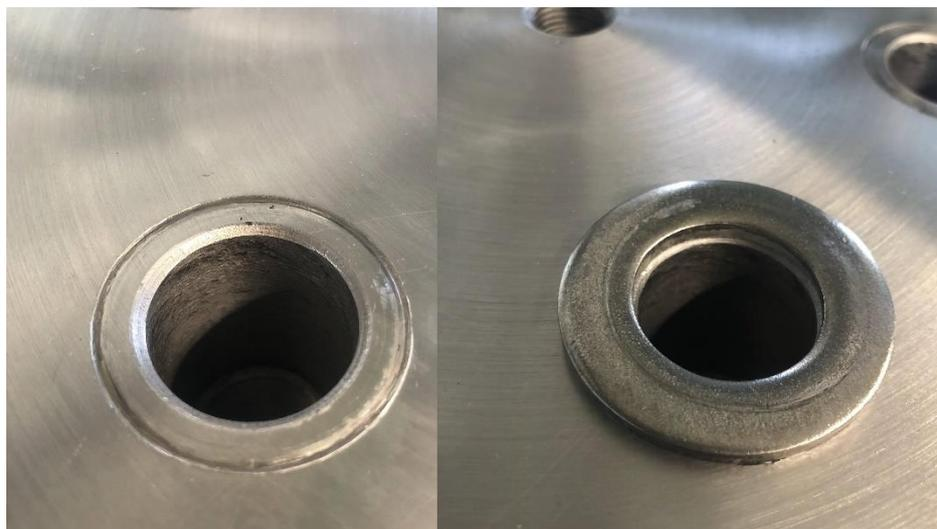
**Figura 2.1.** Orificio sin arandela y orificio con arandela para el tornillo.
