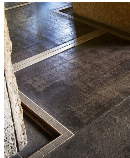
113. i 114. Castelvecchio de Verona. Fotografies de l'espai interior.
