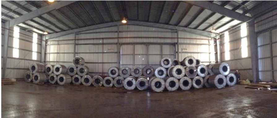
Figura 2.18 Depósito para almacenamiento de grandes bobinas de acero (15 ton), construido con un hormigón con fibras sobre sobre una subbase de baja capacidad portante (Pombo et al., 2020)
