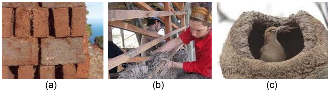
Figura 2.3 (a) Ladrillos de barro con fibras vegetales. (b) Construcción de vivienda con bahareque. (c) Pájaro hornero argentino construyendo nido con barro y fibras vegetales
