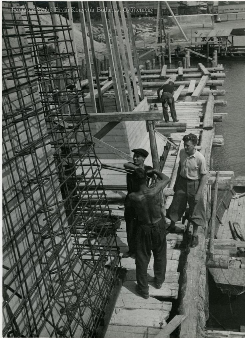
1. kép. A kikötő építési munkálatai, 1920-as évek ( FSZEK Budapest Gyűjtemény 022032 )
