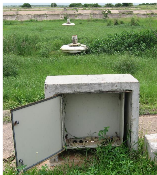
Een verlaten en geplunderde afvalwaterzuiveringsinstallatie nabij Accra, Ghana, lijkt tegenwoordig meer op een grasland. © Diederik Rousseau
