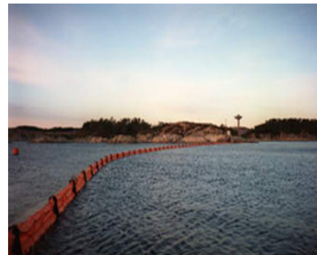
Specifiek systeem om de IJzermond af te sluiten van de zee
