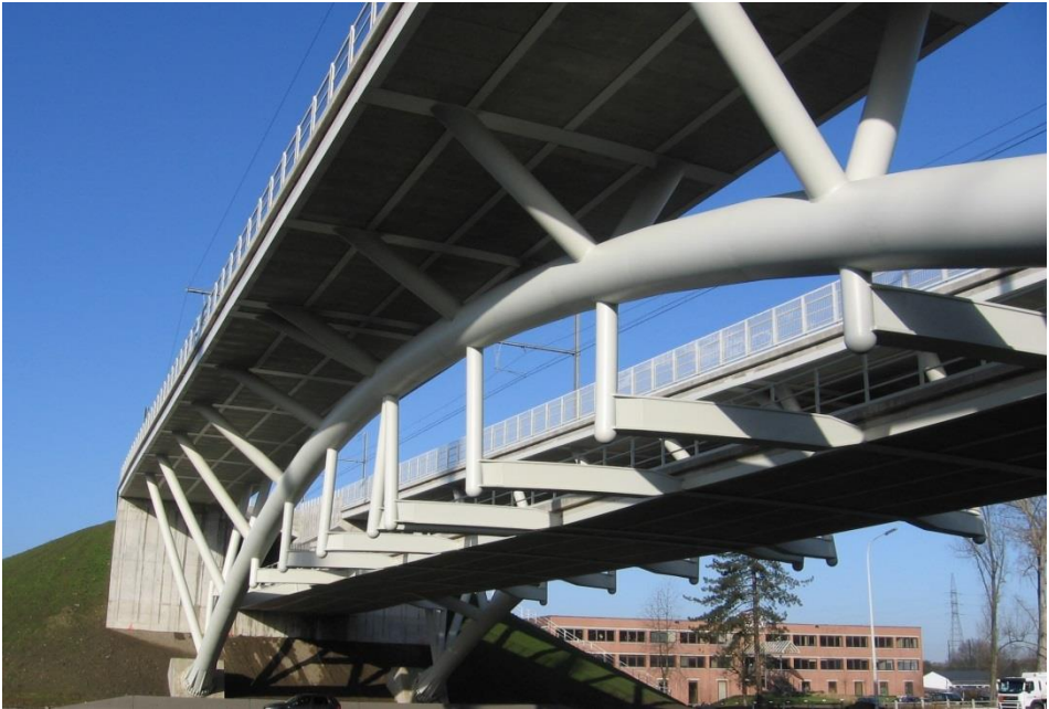
Figuur 1-3: Spoorbrug over de Woluwelaan [2]
