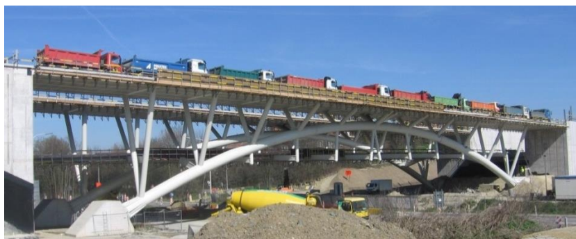
Figuur 6-18: Belastingproef met vrachtwagens (meetpositie 5)
