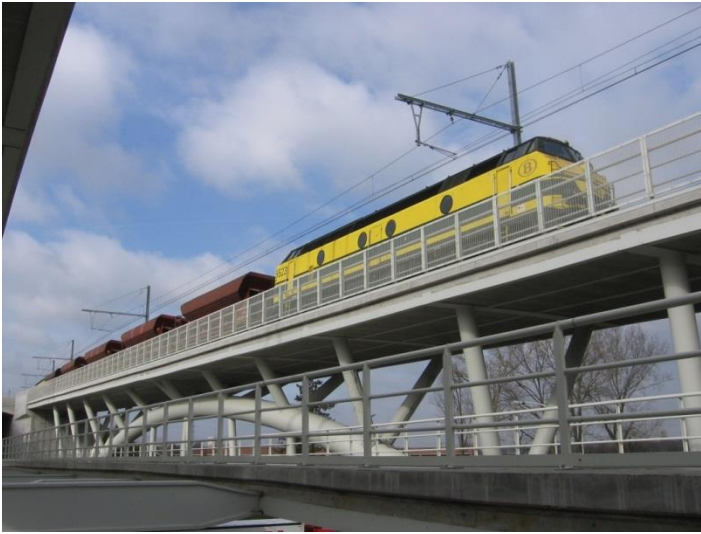
Figuur 6-23: Brugdek AL wordt belast door kleine, rijdende goederentrein
