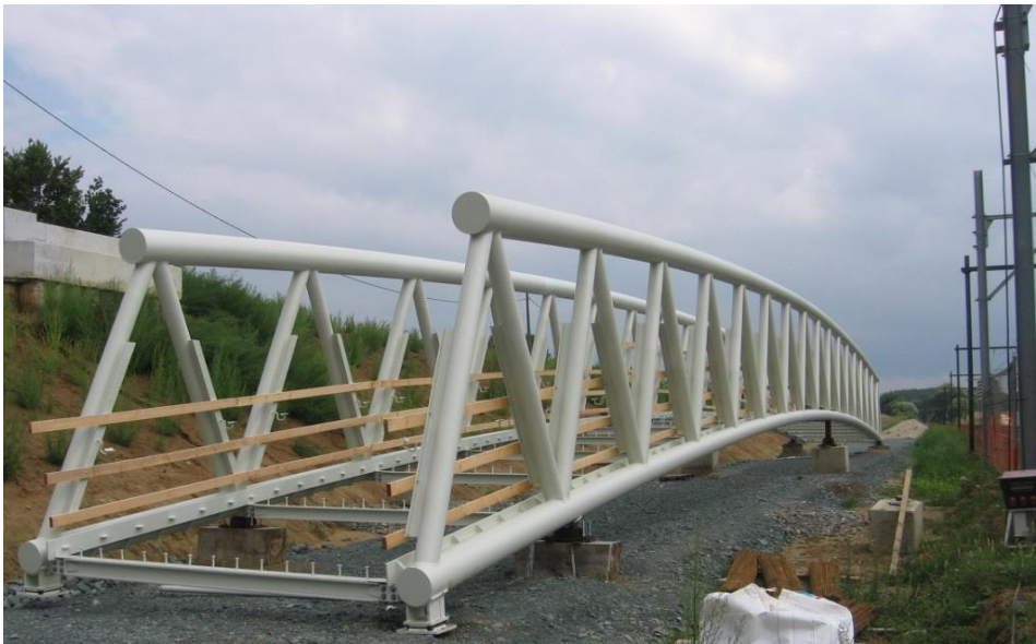
Figuur 1-2: Voetgangersbrug in Dilbeek
