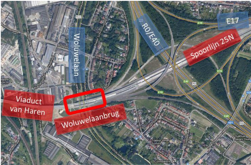
Figuur 6-1: Locatie van de Woluwelaanbrug
