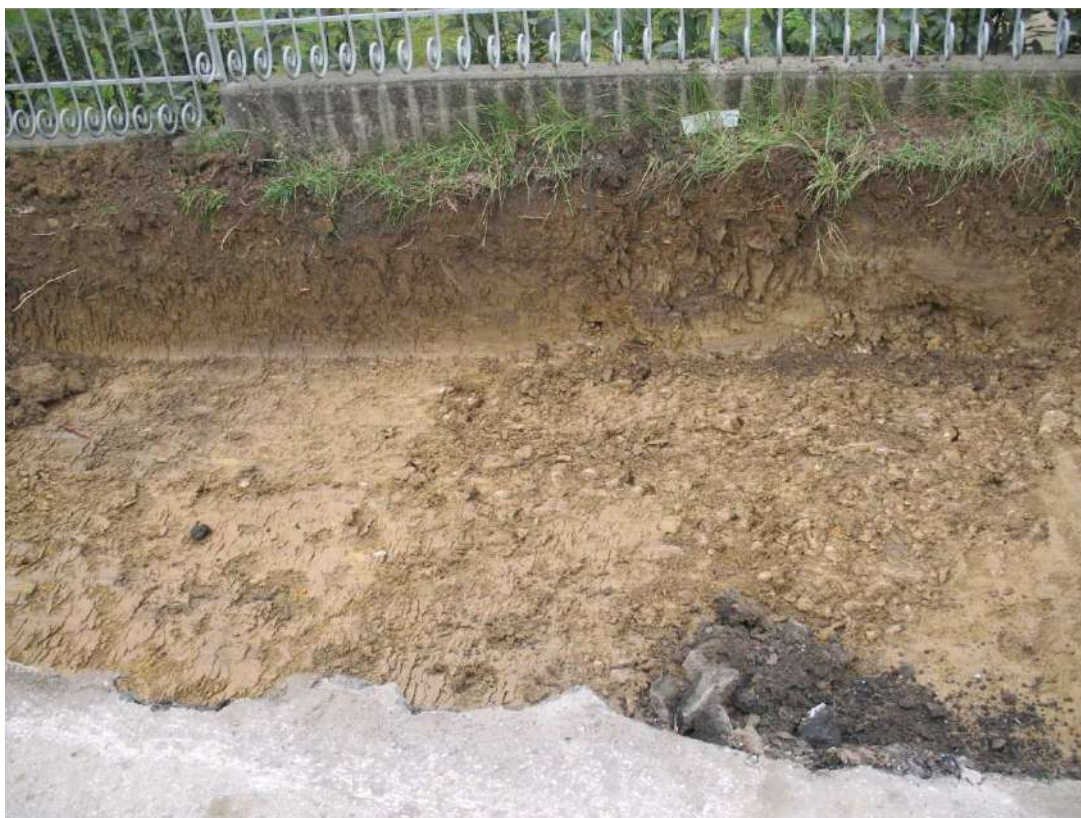
Fig. 6. Area interessata dai lavori stradali lungo via I Maggio, in cui si nota la presenza di un antico alveo con la presenza di ciottoli fluviali (Foto X. Gonzalez).
