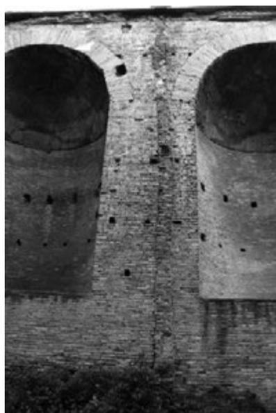
Fig. 8 – Basilica di Massenzio, cd. intercapedine. Settore settentrionale. Giuntura di cantiere visibile nella cortina laterizia (foto Autori).
