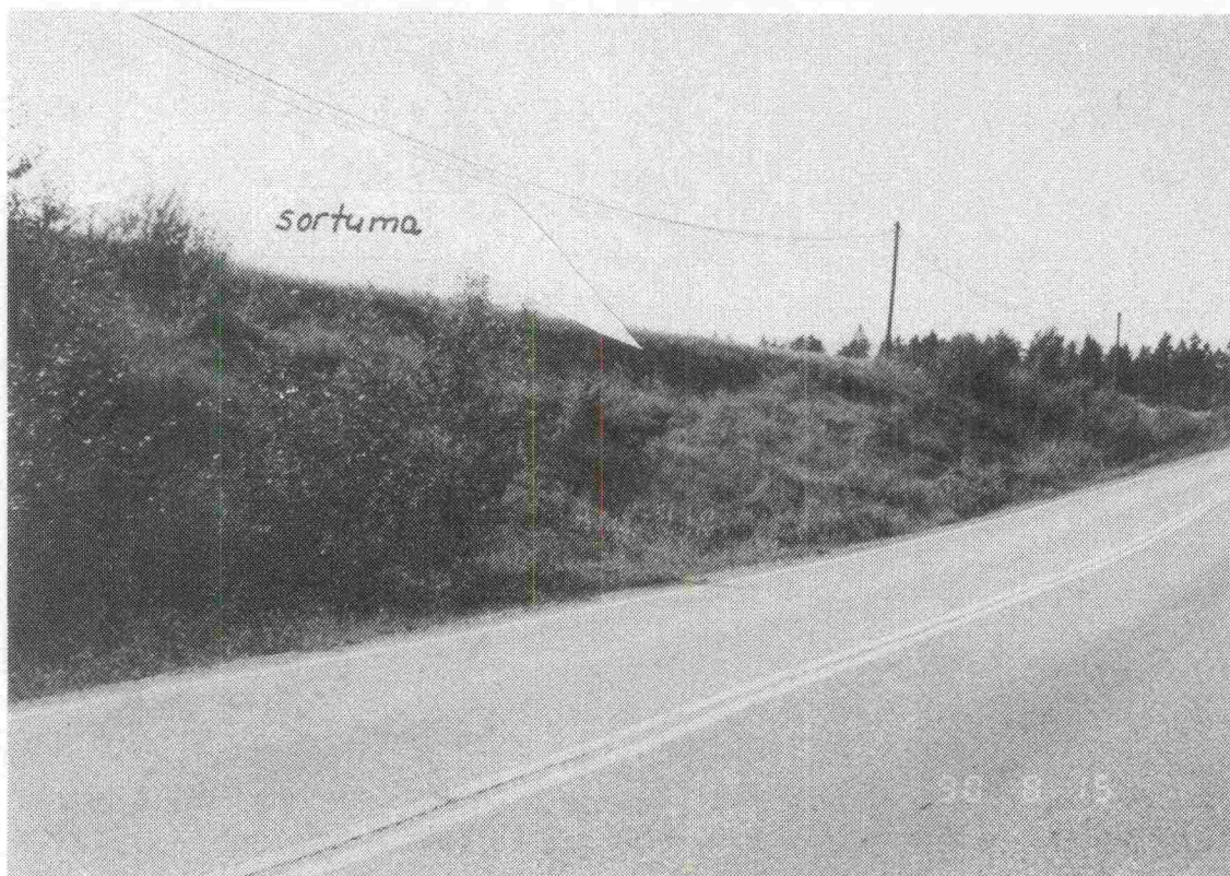
Kuva 2.2. Maantie 139/01 välillä Nurmijärvi-Palojoki. Luiskasortuma . Taulukko 2.1 [TIEL:n Uudenmaanpiirin sortuma-aineisto].
