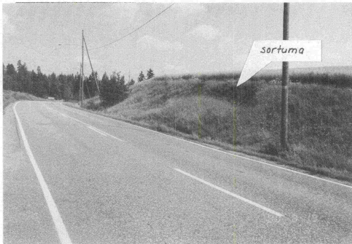
Kuva 2.3. Maantie 149/02 välillä Nikkilä-Mäntsälä. Luiskasortuma. Taulukko 2.1 [TIEL:n Uudenmaanpiirin sortuma-aineisto]
