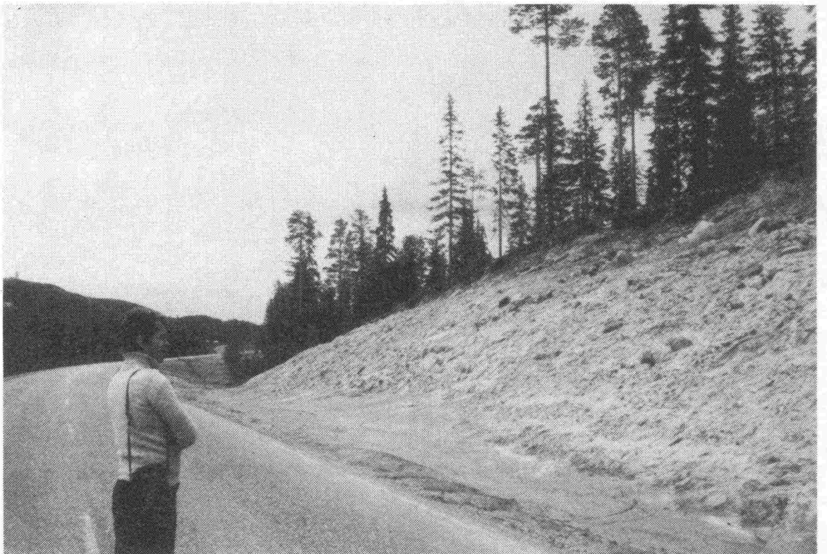
Kuva 2.14. Valtatie 5 välillä Kuusamo-Rovaniemi. Moreeniluiskien sortuminen roudan sulaessa keväällä 1978. Juoksusortuma. [TIEH:N Geopalvelukeskuksen valokuva-arkisto].
