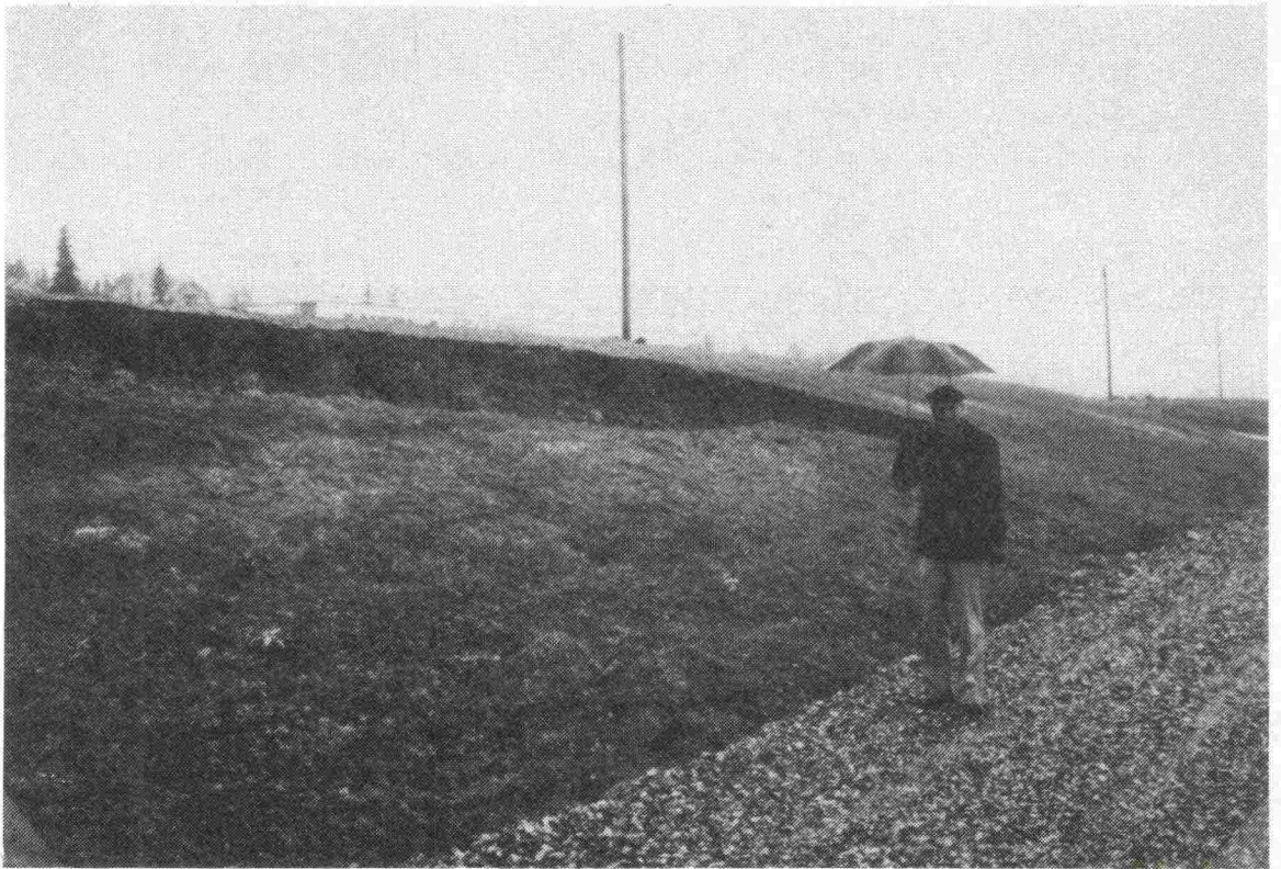
Kuva 2.13. Kantatie 40 Kauselan eritasoliittymän luiskasortuma 1980. Pyörähdyssortuma. [TIEH:N Geopalvelukeskuksen valokuva-arkisto].
