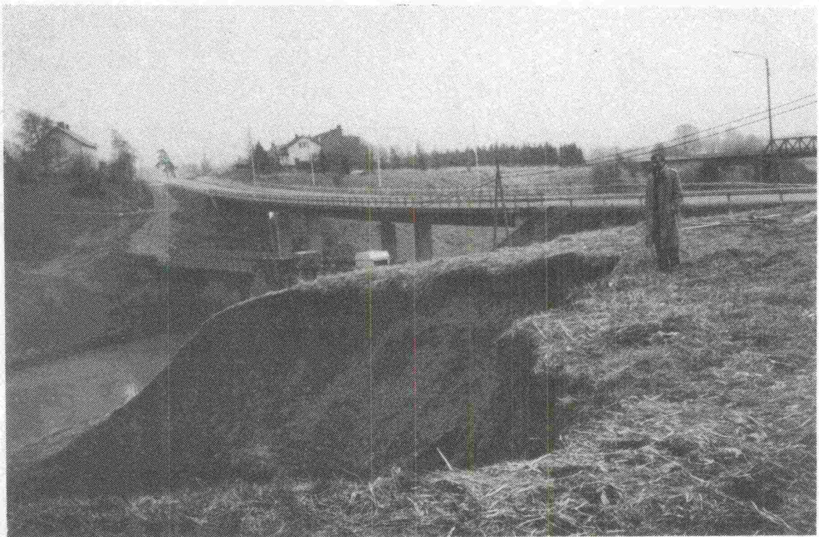
Kuva 2.12. Halikonjoen luiskasortuma. Liukusortuma. [TIEH:N Geopalvelukes- kuksen valokuva-arkisto].
