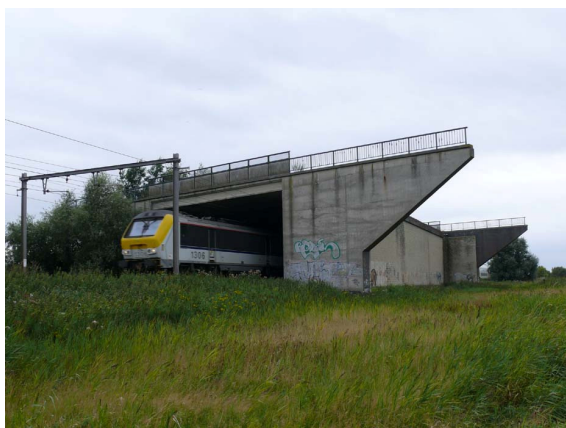
Fig. 5. Spookbrug te Varsenare (Jabbeke), afgebroken in 2012
