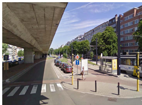
Fig. 6. Zuid-viaduct te Gent, gedoemd om gesloopt te worden?
