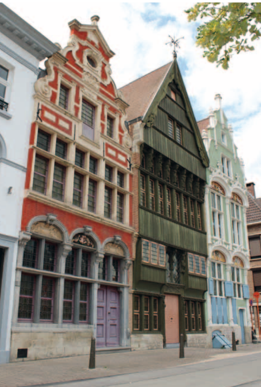
12. Historisch architecturaal ensemble aan de Haverwerf met links het huis Sint-Jozef, dat in 1902 deels met originele materialen werd gereconstrueerd (foto auteur)
