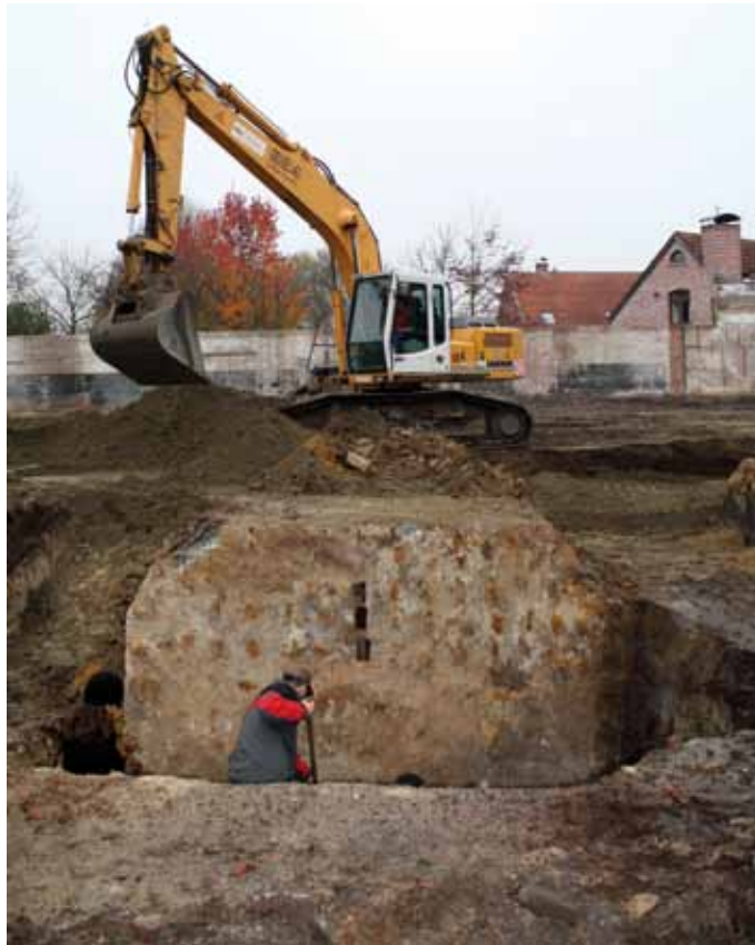
Turnhout - Steenweg op Oosthoven: observatie-/schuilbunker kort na de ontdekking (Foto Jef Van Doninck 2009, © ADAK).
