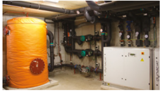
De warmtepomp koppelt de gebouwmassa aan de geothermie
