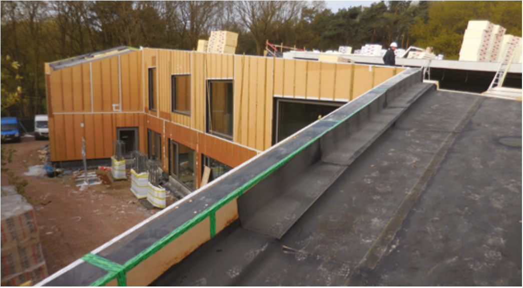
Gevel opgebouwd met prefab houten elementen inclusief isolatie, schrijnwerk en beglazing
