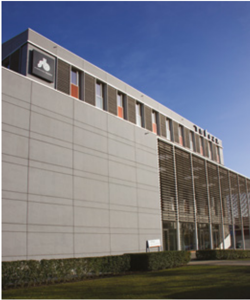
GEOTABS Infrac-Boydens kantoorgebouw te Groot-Bijgaarden
