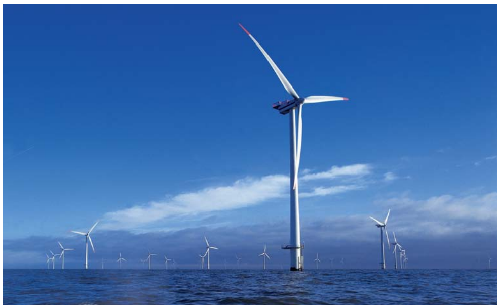
Figuur 1.2: Off-shore windmolenpark met turbines van 2 MW in Horns Reef, voor de kust van Denemarken. ©Danish Wind Industry Association
