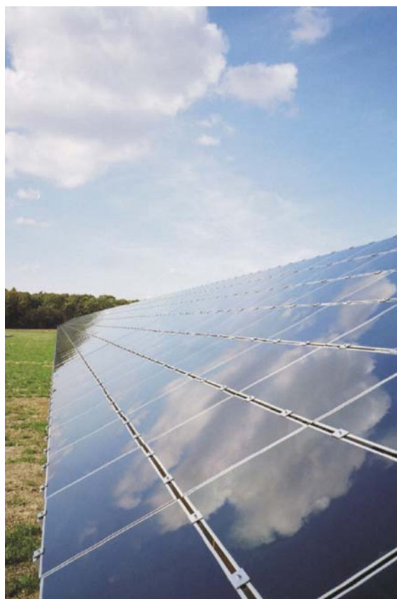
Figuur 1.3: PV-zonnepanelen op basis van CdTe/CdS polykristallijne dunne film. ©Antec Solar GmbH
