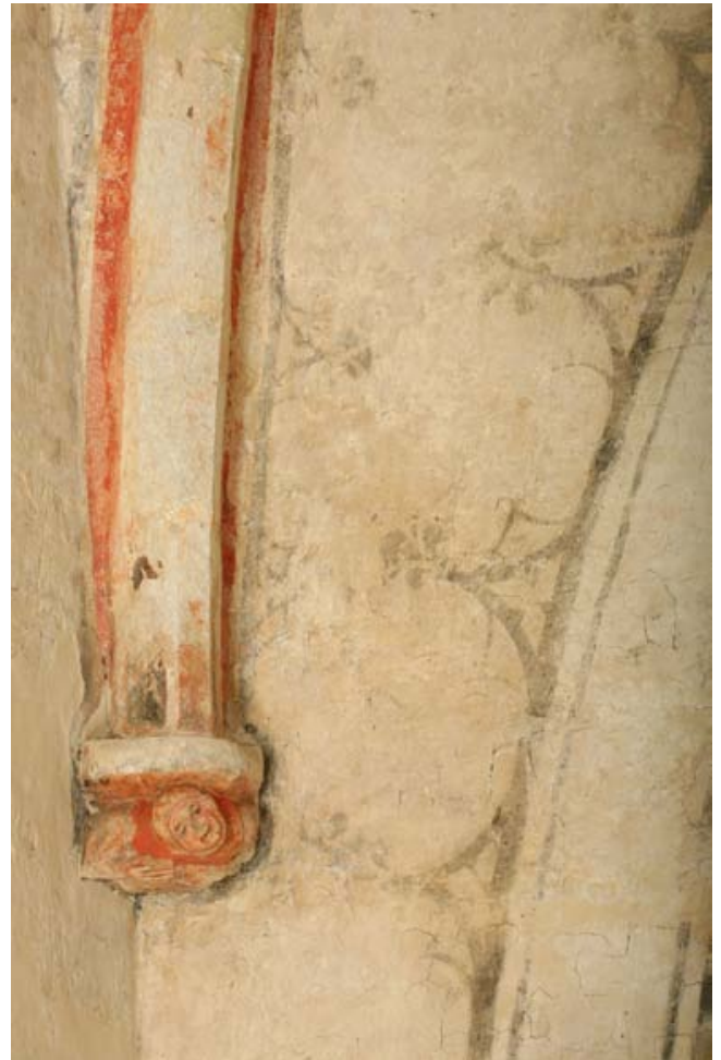
FIG. 23 Detail van de architectuurpolychromie op de ribben van het gewelf. Detail of the polychrome architectural elements on the ribs of the vault.
