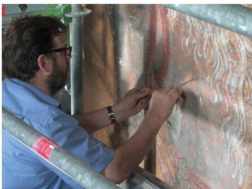
FIG. 85 Het opvullen van de gaten met traditionele kalkmortel. The holes were infilled using traditional lime mortar.
