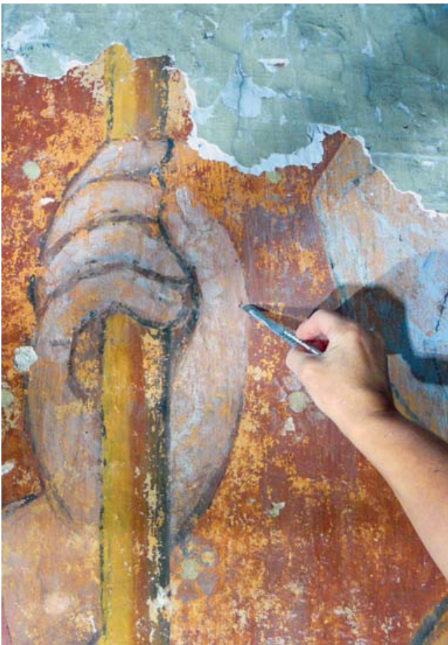
FIG. 83 Het verwijderen van ongeveer vijftien kalklagen met een chirurgische scalpel. For the removal of ca fifteen lime layers a surgical scalpel was used.
