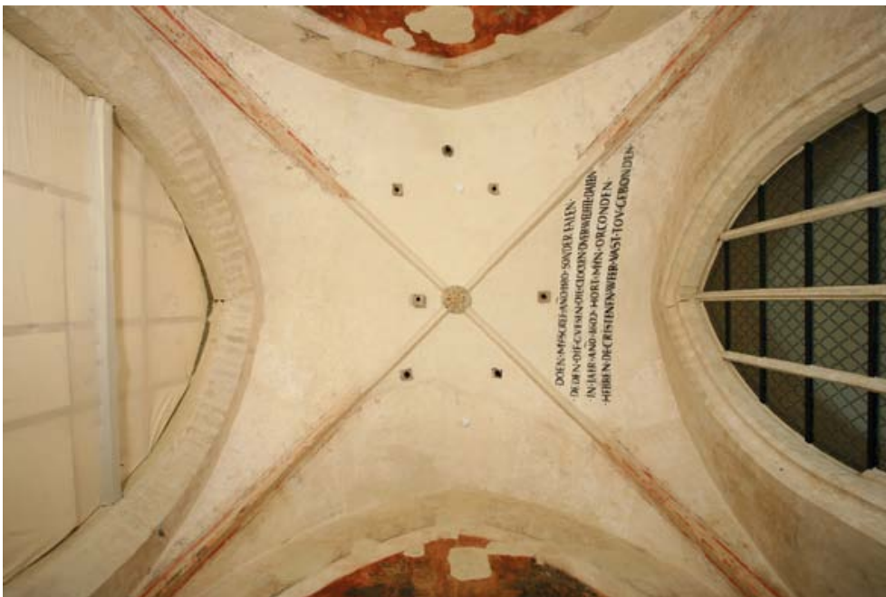
FIG. 16 Algemeen zicht op het gewelf van de torenruimte.
