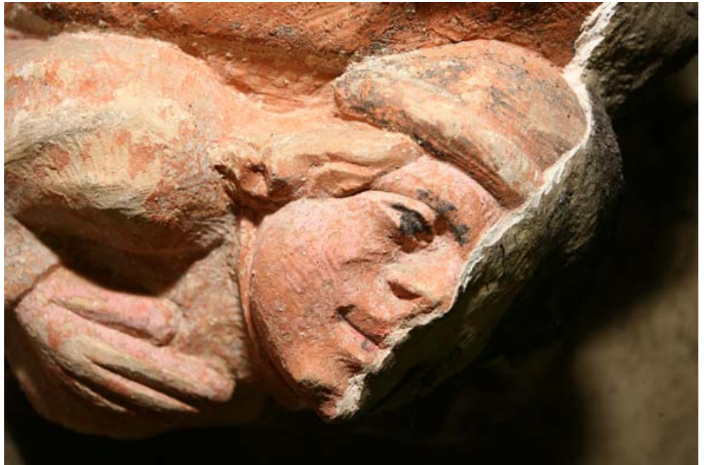
FIG. 26 Half blootge- legde kraagsteen met dui- delijke sporen van het steenkappersgereedschap. Semi-revealed corbel with clear- ly visible tool marks.
