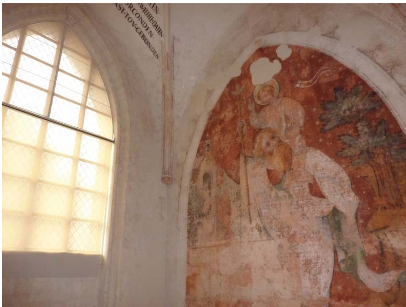
FIG. 87 Afscherming van het glasraam dat te veel licht en UV-stralen doorliet (foto E. Jacobs, OE). As the window let in too much UV light, a UV filter was applied (photo E. Jacobs).
