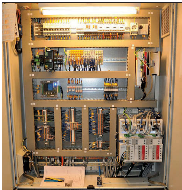
EtherCAT stuurt over één kabel alle I/O's en servodrivens aan
