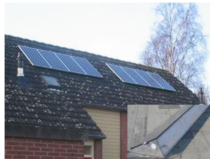
Figuur 2: vast opgesteld, geïntegreerd in dak (gesloten)
