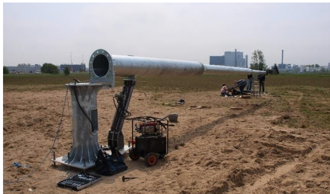
Figuur 45. Hydraulisch kantelbare monopole
